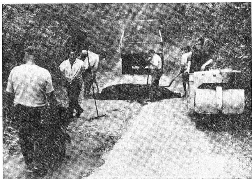
Les ouvriers mettent la dernière main au rhabillage de la chaussée.
