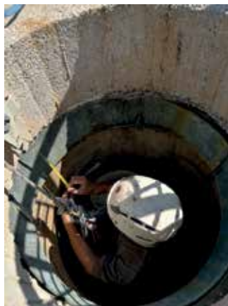
Sanacija dimnika — izvedba
