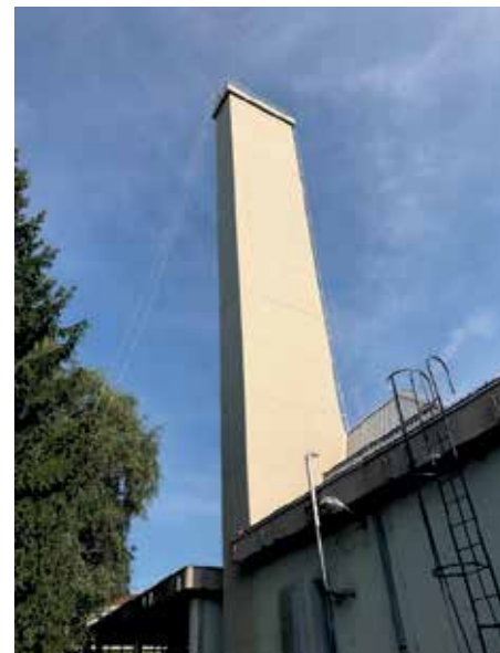
Dimnik po sanaciji — zunanost
