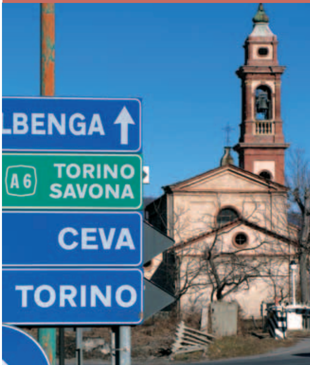
Il completamento della rete autostradale savonese, con le due bretelle Albenga-Garessio-Ceva e Carcare-Predosa, può essere realizzato con il ricorso alla finanza di progetto
