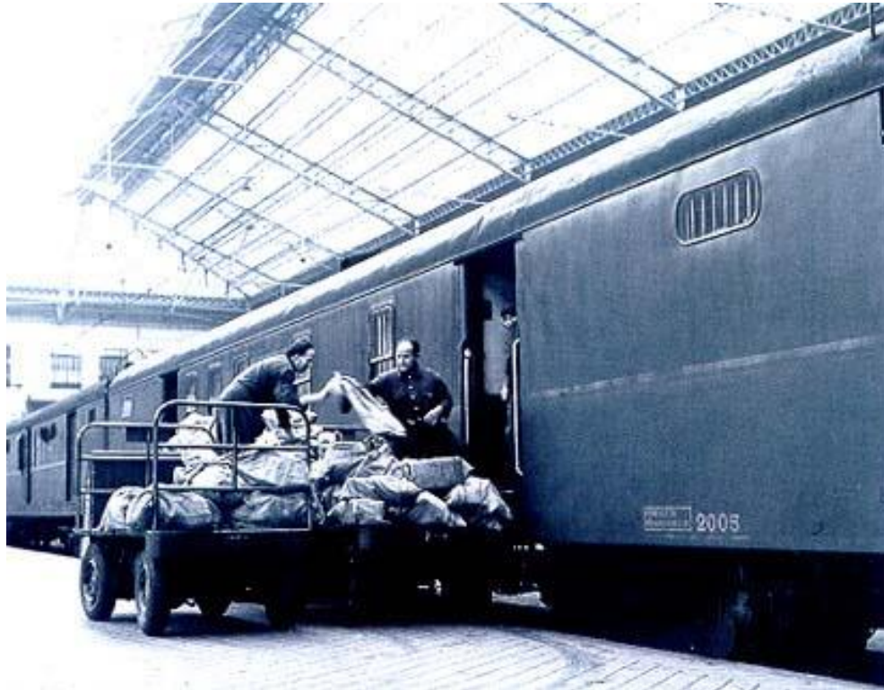
Foto 40.- A la llegada del tren a destino los Subalternos se encargan de descargar las sacas de correspondencia del coche-estafeta DGCT 2005. (Foto: Postal CORREOS)
