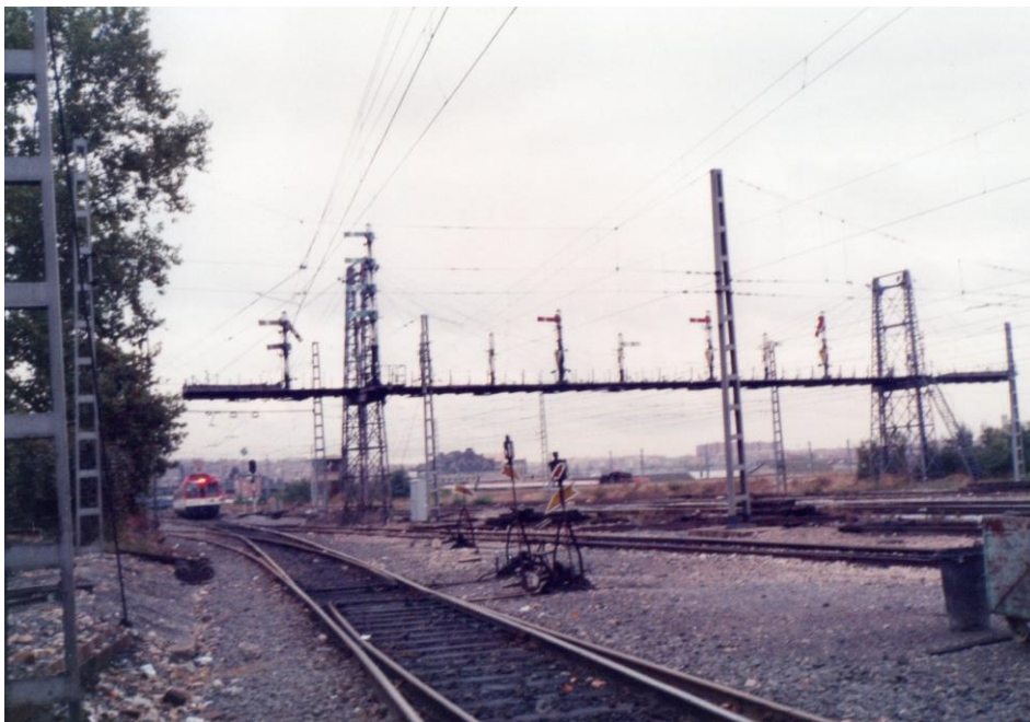
Foto 21.- Puente de señales a la salida de Madrid Atocha. (Foto: Diego Tárraga Vives)
