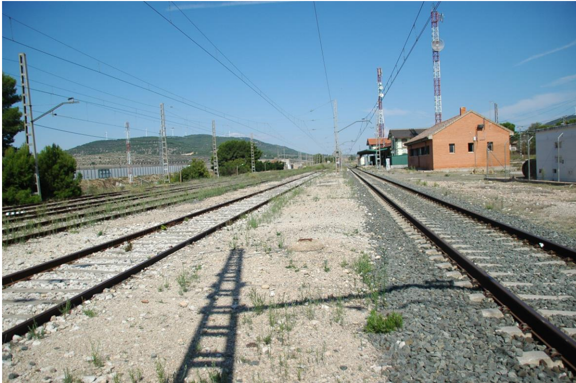
Foto 37.- Pabellón de Correos de La Encina, vías 4 y 6 (lado Alicante) y las colaterales 8-10-12. (Foto: Diego Tárraga Vives)
