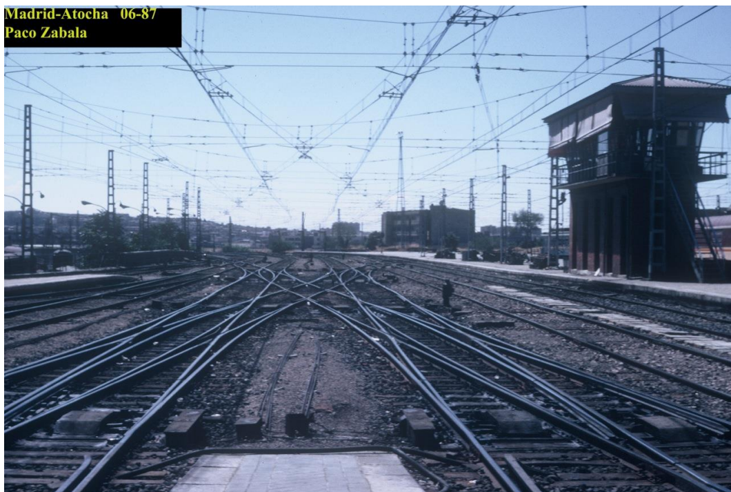
Foto 33.- Travesías de unión doble (TUD) en las vías de Madrid-Atocha. (Foto: Paco Zabala)
