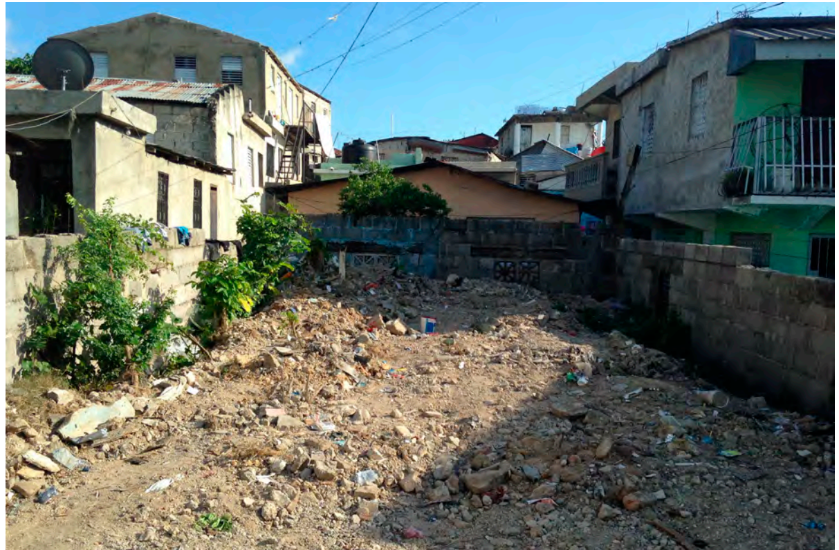
Ilustración 7.3 El solar en la Avenida Emma Balaguer fue limpiado durante el trabajo en marzo
