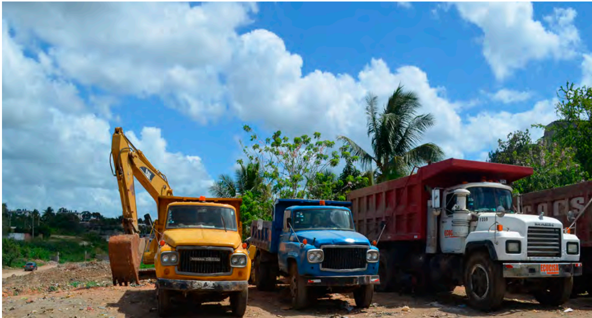
Ilustración 1.4 Máquinas de la OISOE estacionadas en La Piscina
