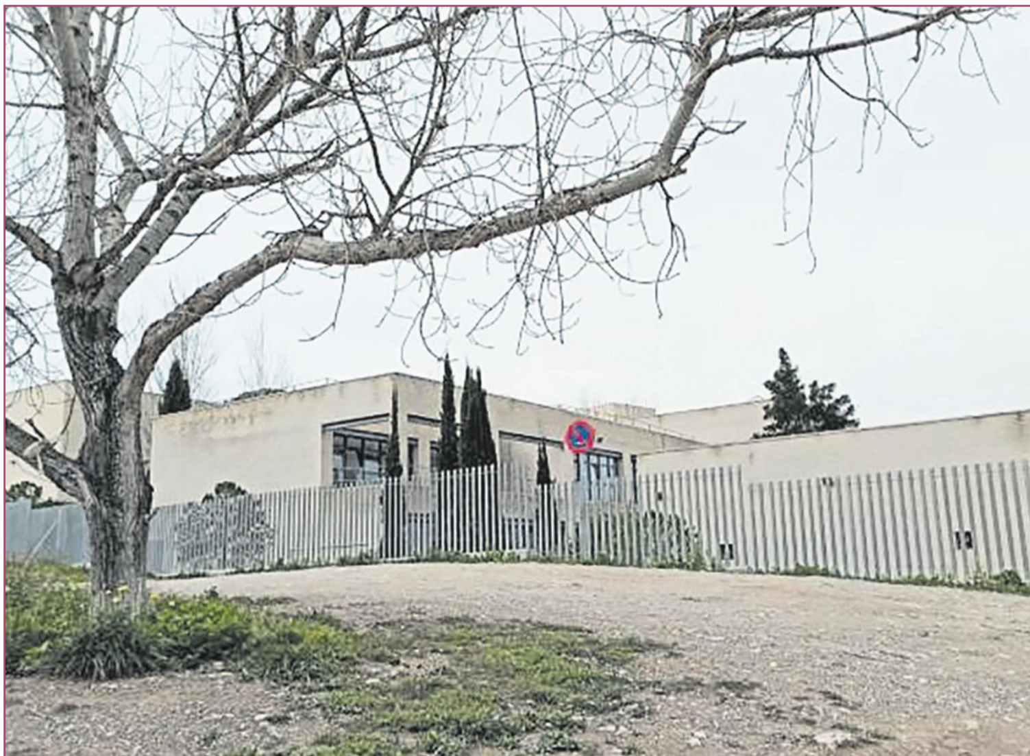
Imagen de la parcela sobre la que se edificará el Centro de Día.
