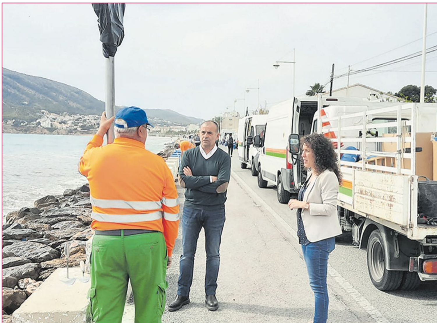
Aurora Serrat y Deo Sánchez supervisan las tareas de eliminación del semáforo.
