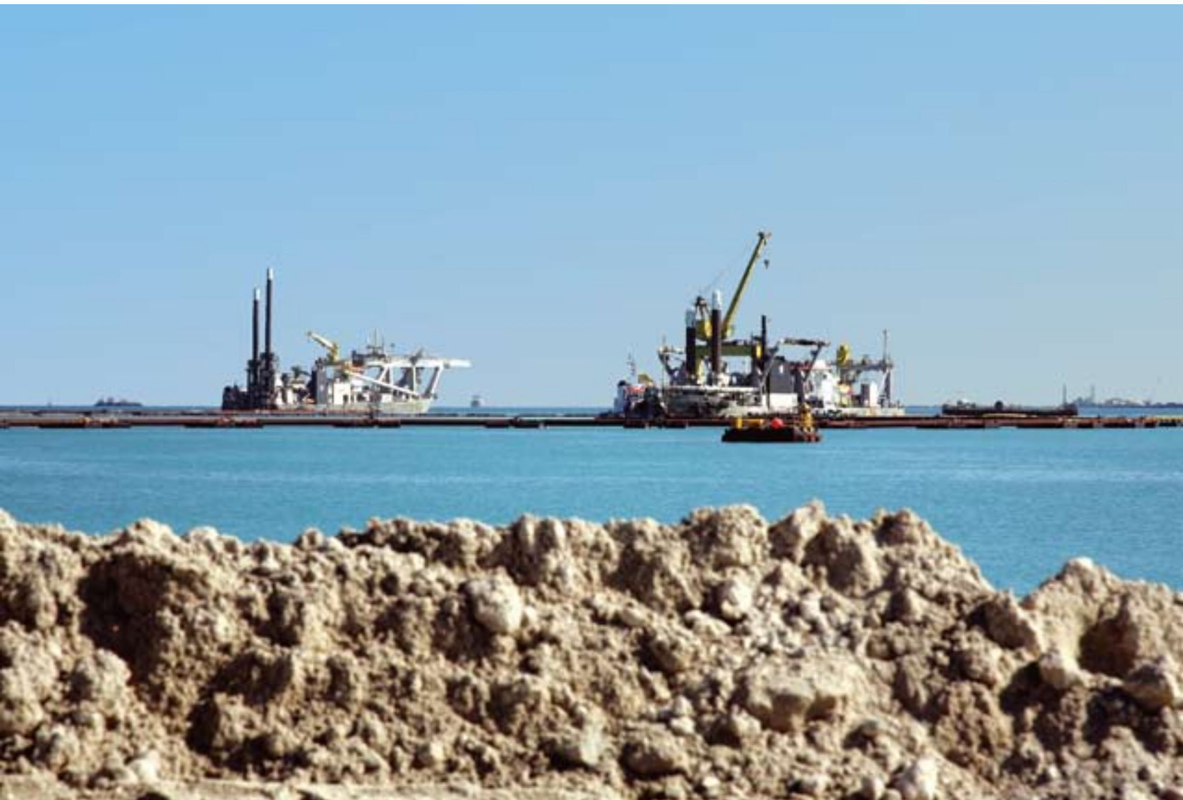
Boskalis en Archirodon werken samen aan de aanleg van een nieuwe buitengaatse haven in Khalifa, Abu Dhabi.
