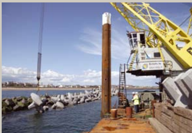
Boven: Om de baai van de Engelse kustplaats Newbiggin te beschermen legde Boskalis een golfbreker aan van 50.000 ton rotsen die op een mat van geotextiel op de zeebodem werd gestort. De golfbreker werd omgeven door een beschermende laag van 'Core-locs'.
