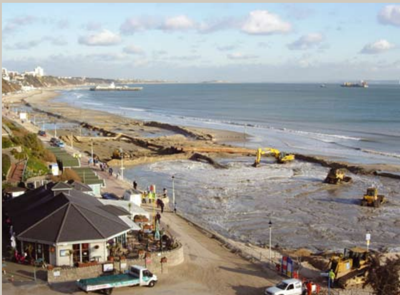
Kustbeschermingswerkzaamheden in Bournemouth, Verenigd Koninkrijk, waarbij 700.000 m 2 zand aan het strand is toegevoegd.
