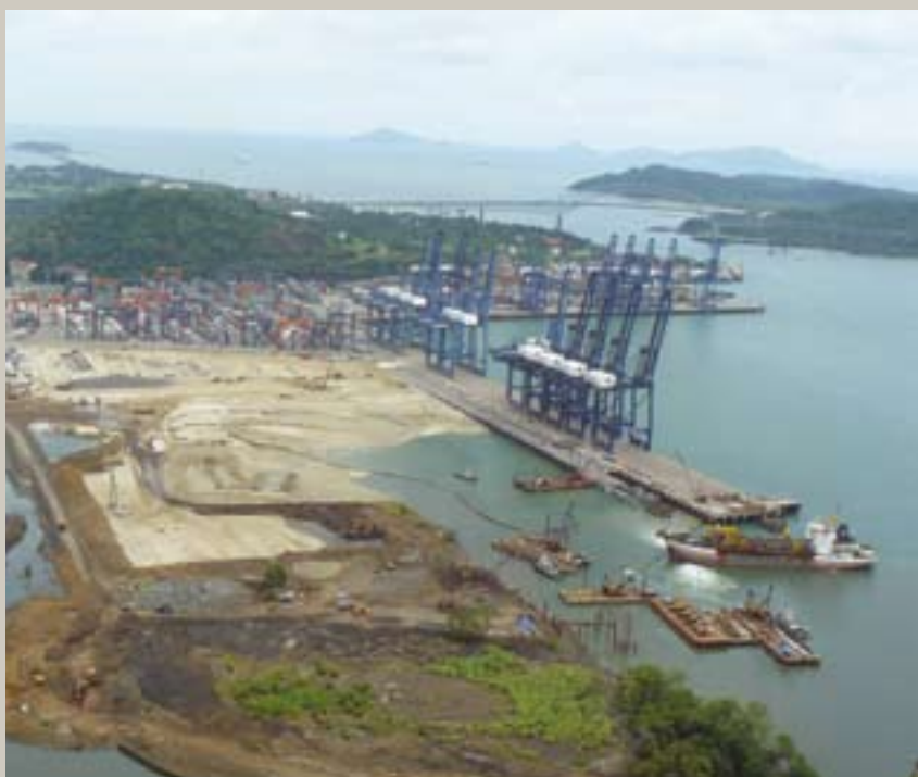
Boven: Werkzaamheden ten behoeve van de uitbreiding van de containerhaven van Balboa, Panama, aan de Pacific monding van het Panamakanaal. Het project omvat de aanleg van een nieuw haventerrein, een beschermende rotsdijk en een verbinding met de bestaande kades.
