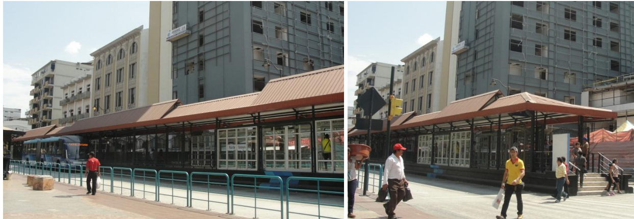
Imagen 50. Caseta tipo, calle Pedro Moncayo, 2013. Fuente: Propia
