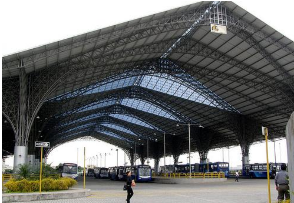
Imagen 52. Estación de integración, Río Daule. ( Skyscrapercity, Infraestructura y medios de transporte )
