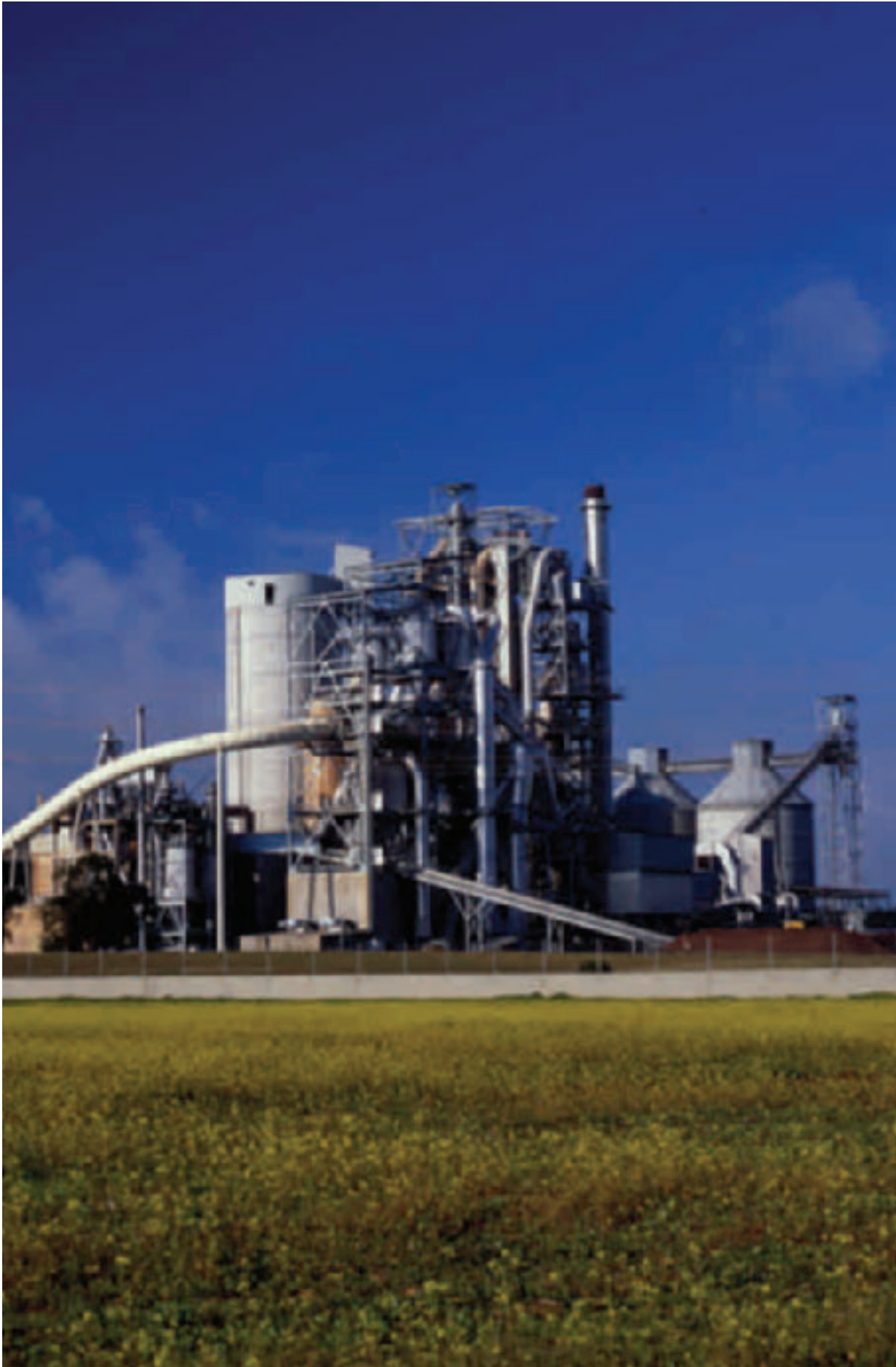
Fábrica de Alcalá de Guadaíra, Sevilla, España.
