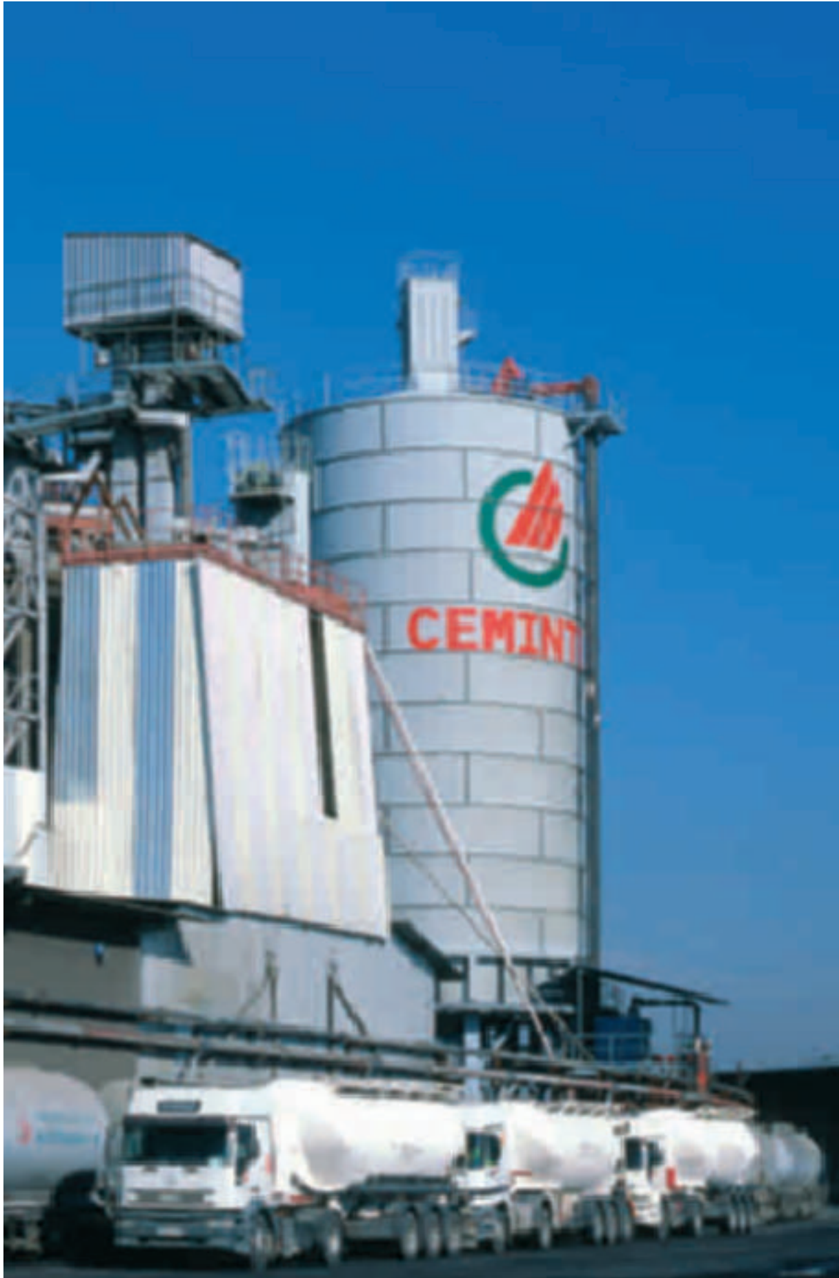
Instalaciones de Ceminter, Madrid, España.
