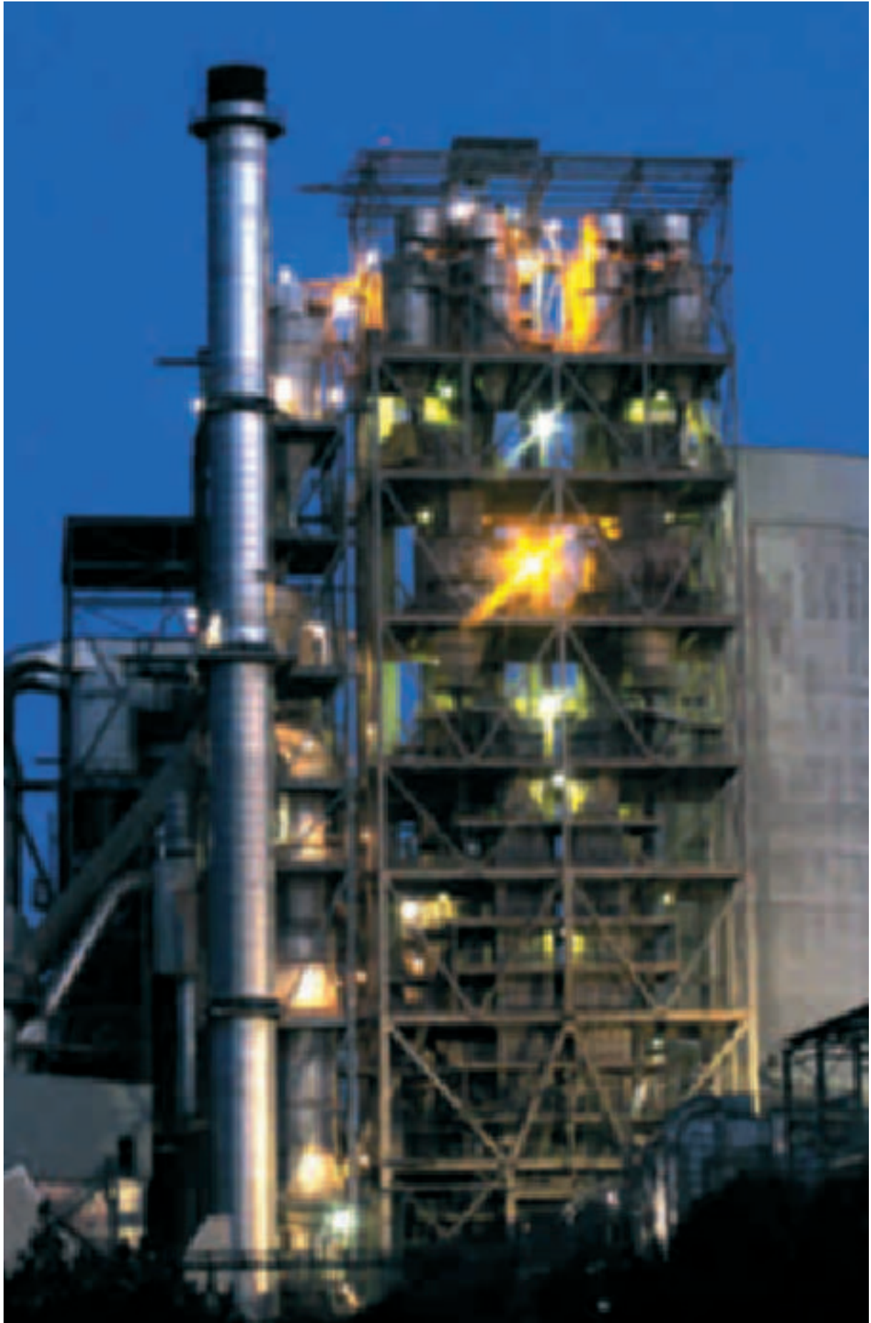
Fábrica de Alcalá de Guadaíra, Sevilla, España.
