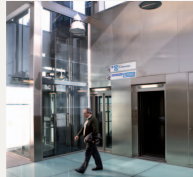
Estación remodelada de FGC en la plaza Molina.
