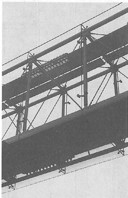
Details of the new bridge. Photo: Van der Vlugt & Claus.
