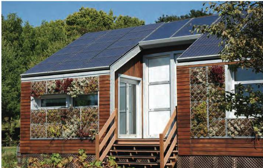
Tejado formado por paneles solares
