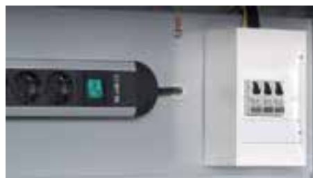
Abb.: Verteilerkasten, Schutzklasse IP30 mit Einzelphasen-Absicherung
