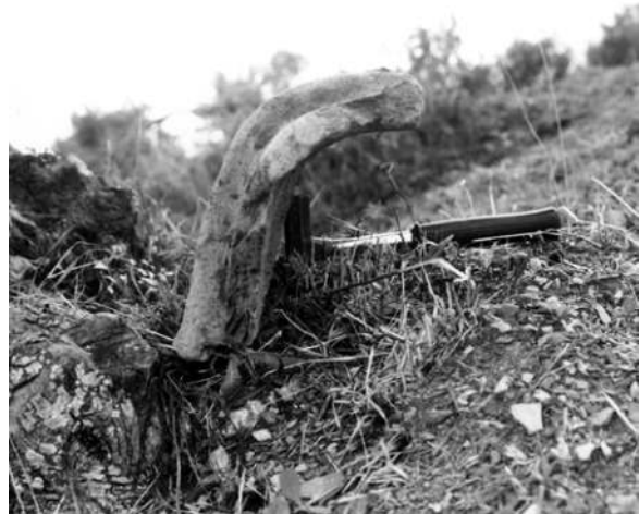
Figure 9 – L'acquedotto: canale ad 'U'.
