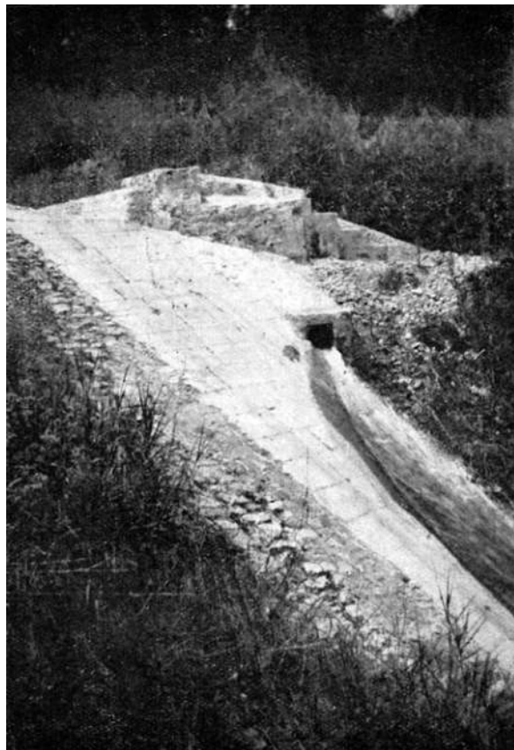
Figure 7: Source de Favara. Ouvrages de protection et déversoir (d'après Cingolani et al. 1935-1937), Bibliothèque municipale de Termini Imerese (publication autorisée le 4 Février 2020).
