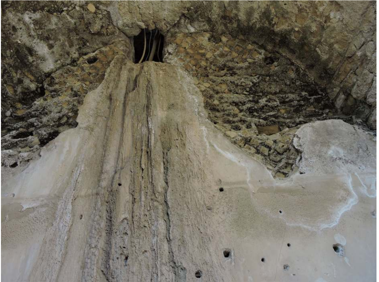
Figure 9: Sbocco del diversorium del Serino (foto: D. De Simone).
