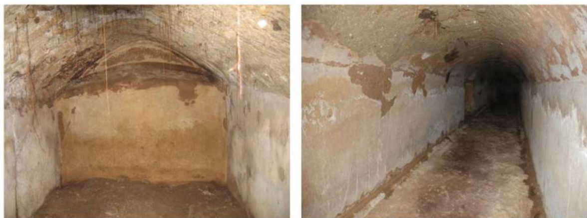
Figure 4: Particolari della cisterna C2 della Villa dell'Ambulatio.
