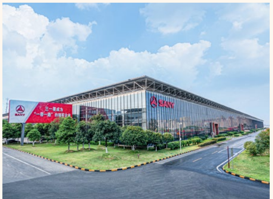
Parque Industrial de SANY en Changsha
