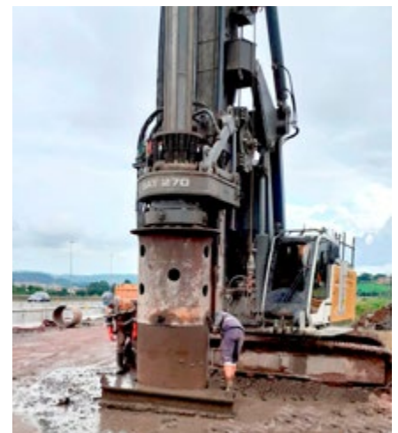
La LB 24-270 fue capaz de introducir la camisa recuperable con el propio par de la mesa de rotación, así como extraerla sin necesidad de una entubadora. Esto es de vital importancia, ya que permite un ahorro sustancial de medios, espacio y tiempo.
