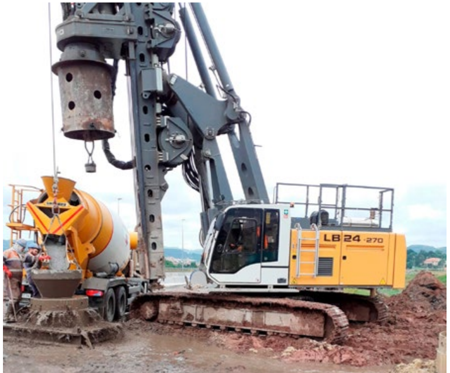
Perforación de pilotes encamisados de gran diámetro, 1.000, 1.200 y 1.500 milímetros, con utilización de tubería recuperable, gracias a una pilotadora de rotación LB24-270 de Liebherr.
