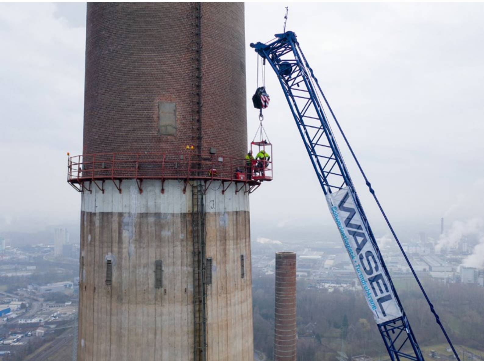
Altura vertiginosa: asegurados con equipos de seguridad, los expertos en explosivos se suben a su plataforma a una altura de 140 metros.
