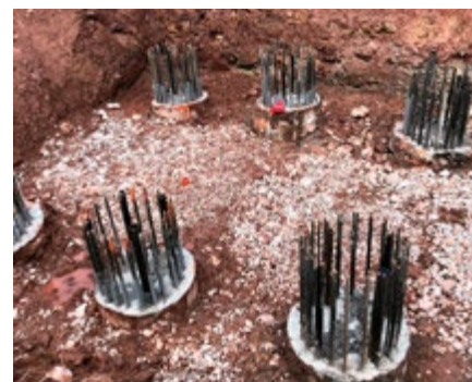
Se trata de un proyecto de gran dimensión y complejidad, para un total estimado de 40.000 metros lineales de pilotes.
