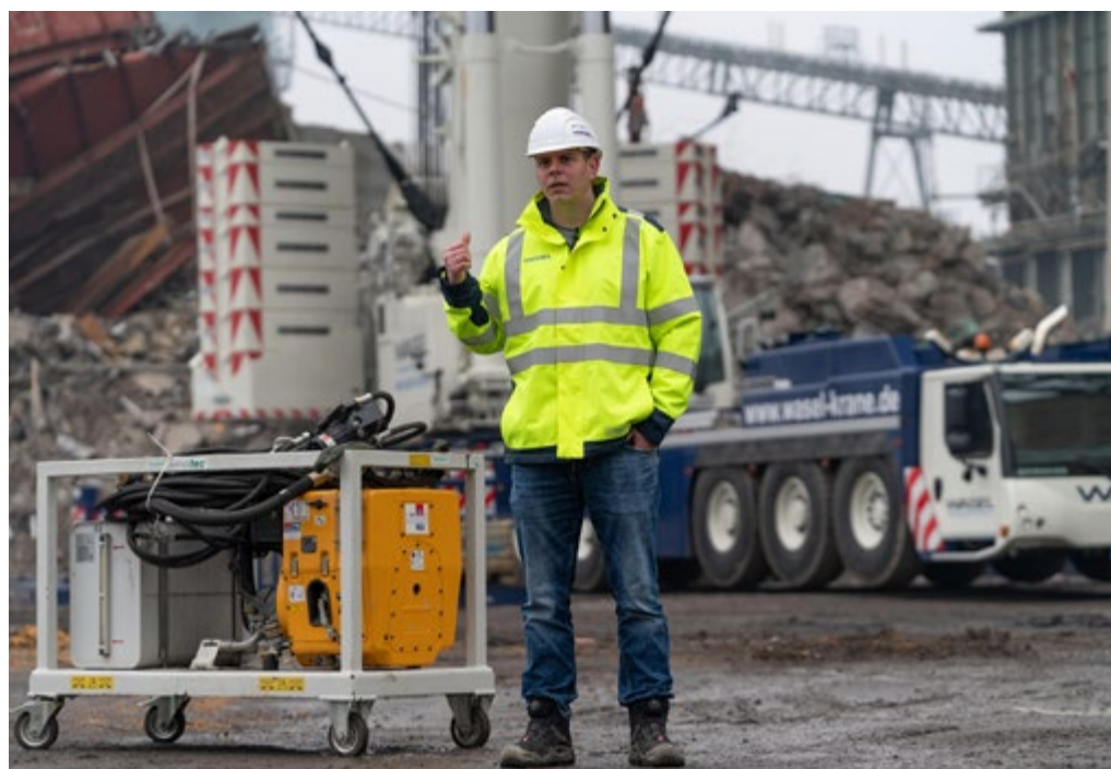
En caso de emergencia, el director del proyecto, Maurizio Ising, explica cómo funciona la unidad hidráulica para permitir que la jaula de seguridad, ubicada en el gancho de la grúa, se baje en cualquier momento si el motor de la grúa sufre un fallo.
