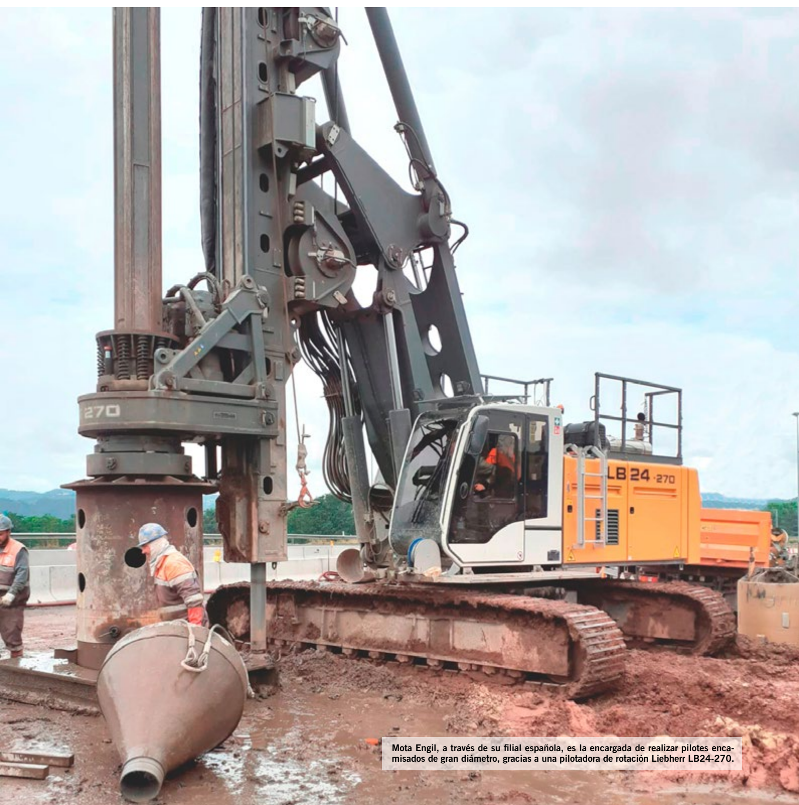
Se trata de un proyecto de gran dimensión y complejidad, para un total estimado de 40.000 metros lineales de pilotes.
