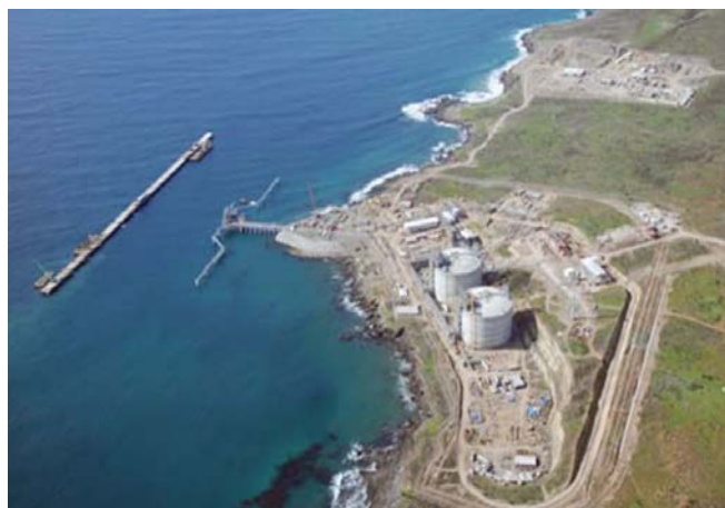
Energia Costa Azul Terminal
