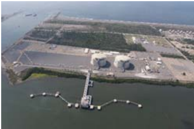
Manzanillo LNG Terminal
