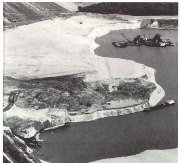
De winning van Beton- en metselzand in het ontgrondingsgebied Bergerheide.
