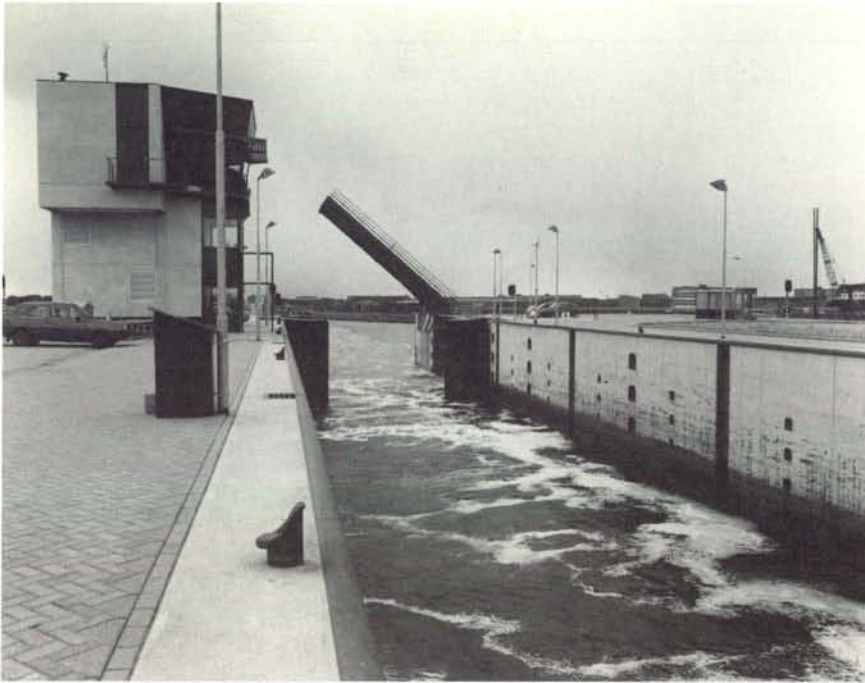
De nieuwe Koopvaardersschutsluis te Den Helder voor gebruik gereed.
