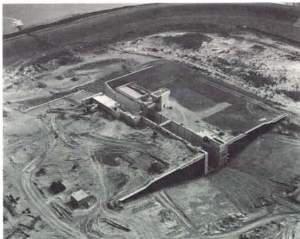
Bergsediepsuis in ruwbouw gereed. De sluis moet ervoor zorgen dat de scheepvaart Bergen op Zoom kan blijven aandoen na het gereedkomen van de Oesterdam.
