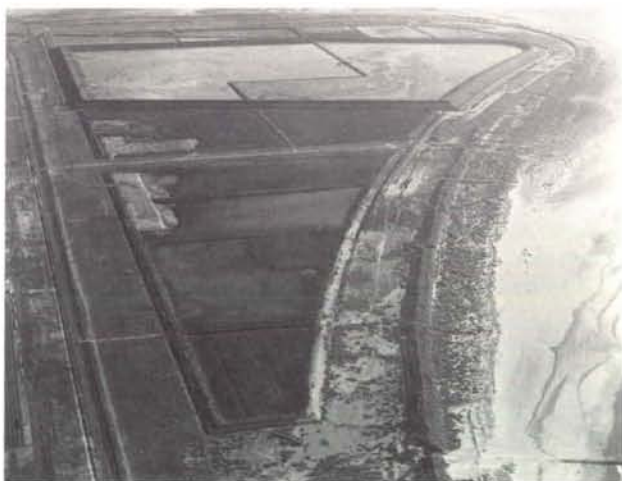
De tijdelijke bergingslocatie voor baggerspecie op de Maasvlakte de zg. badkuip.
