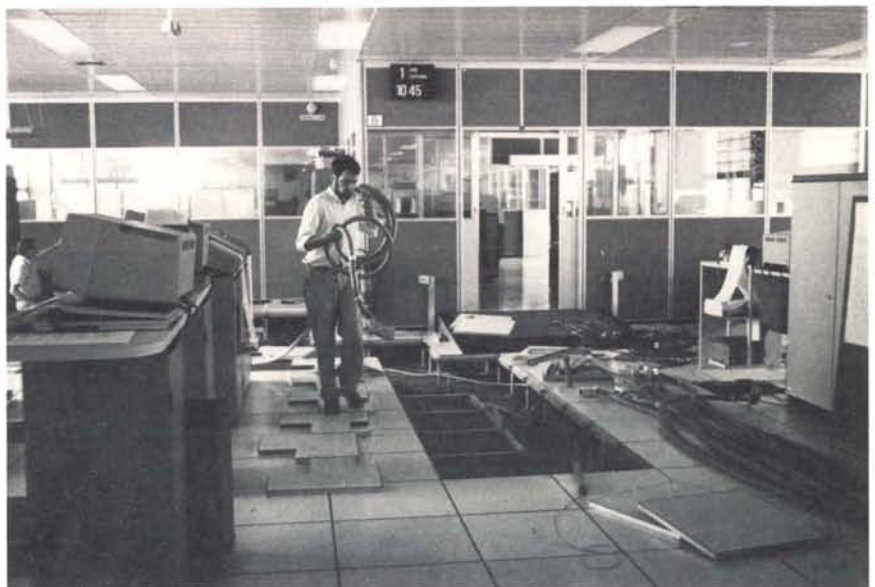
Ter verbetering van de computerfaciliteiten, hetgeen nodig is ter voldoening aan de ontstane wensen, wordt een nieuwe centrale RWS computer geïnstalleerd. Voor de nieuwe computer is een verbouwing nodig, de foto toont het leggen van de bekabeling.
