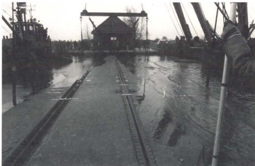
Plaatsing van een balgstuw in het Noordhollands kanaal. Deze BWO-kering is bestemd om in geval van een breuk in een kade of kanaaldijk de gevolgen (overstroming) te beperken.
