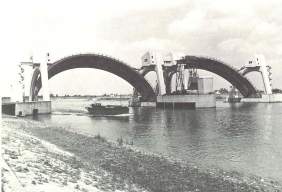
Stuw bij Hagestein, een voorziening ten behoeve van de waterhuishouding.
