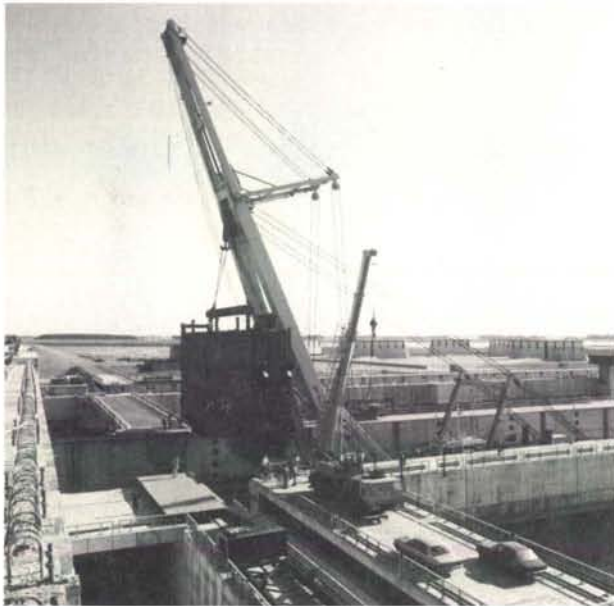
Inbrengen van een roldeur in de Krammersluizen. De scheepvaart maakt gebruik van de sluis voor het passeren van de Philipsdam, één van de nog te sluiten compartimenteringsdammen.
