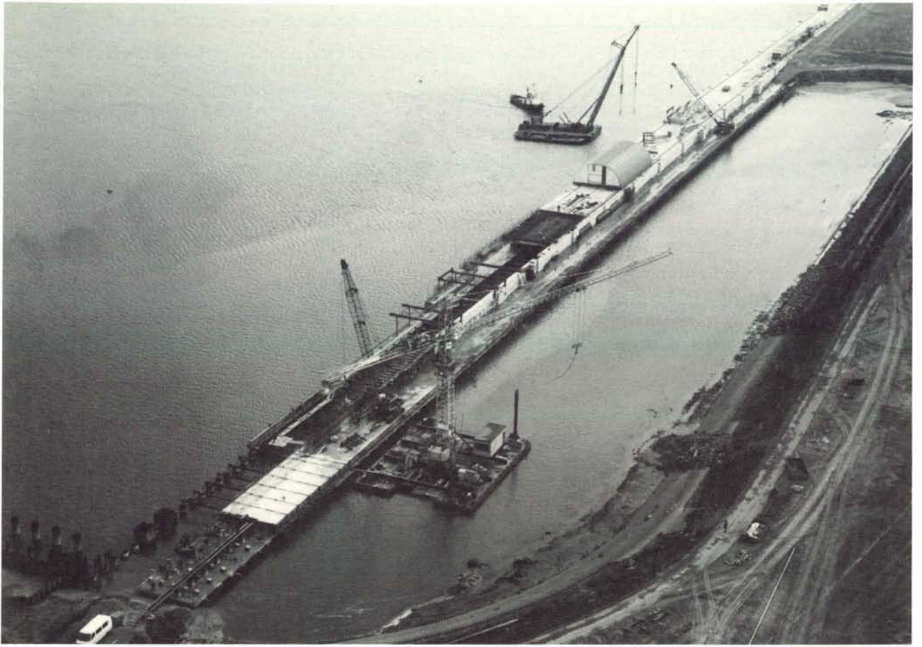
Aanleg kademuur in de Eemshaven te Delfzijl. Door de aanleg van nieuwe voorzieningen wordt een voortzetting van de geleidelijke groei van de op- en overslagactiviteiten verwacht.
