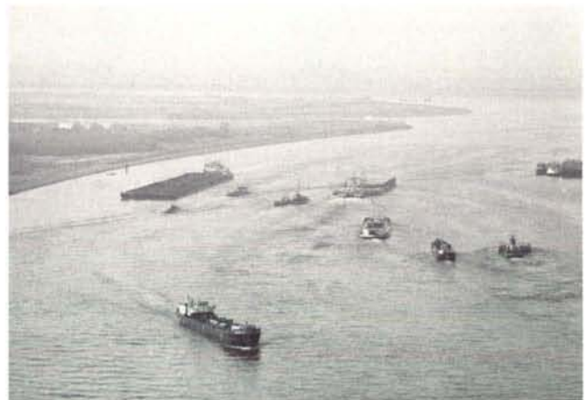
Natte infrastructuur, de Oude Maas één van de belangrijkste vaarwegen ter hoogte van de spoorbrug te Dordrecht.
