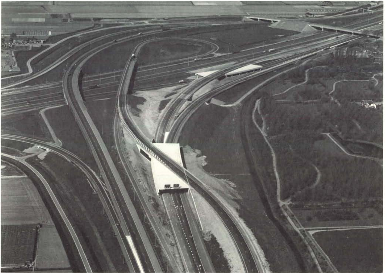
Opname van het uitgebouwd wegenselsel van de rijkswegen 15 en 16 ter hoogte van Ridderkerk wat in 1985 greed kwam.
