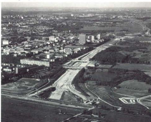
De aanleg van rijksweg 4 vordert gestaag, hier het gedeelte van Ypenburg (rechtsboven) tot de Prinses Beatrixlaan (onder).
