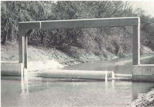
Heuvelstuw te Spijk in het kanaal De Wild. Het kanaal vormt de grens tussen Nederland (rechteroever) en Duitsland. De bouw van de stuw bleek nodig voor het verbeteren van de waterhuishouding.
