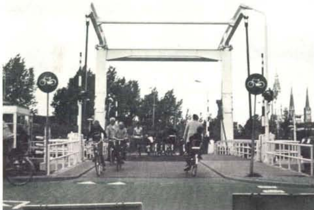
Fietsbrug over het Rijnschiekanaal te Delft, één van de voorzieningen van het Delftse fietsroute-netwerk.
