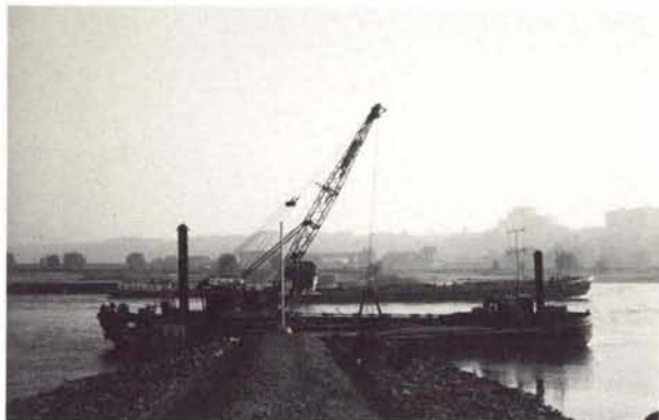
Bochtverbetering van de Waal te Nijmegen, het inkorten van een krib.
