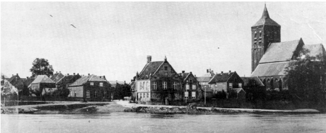
Fig. 19b Het Maasfront van Cuijk is niet bedijkt: de natuurlijke bogte bood voldoende zekerheid tegen de sterk wisselende waterstanden op de Maas
