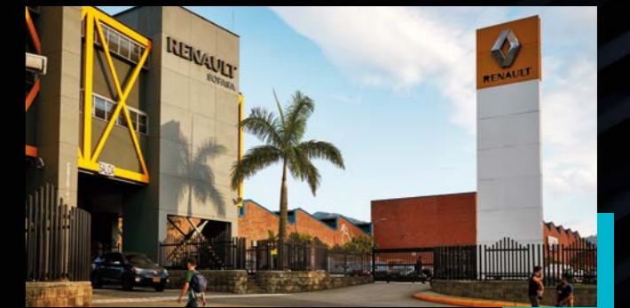
L'USINE D'ENVIADO SOFASA À MEDELLIN EN COLOMBIE.
