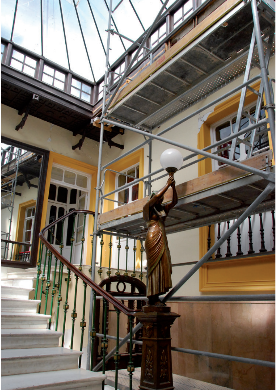
FIGURA 15. DAÑOS OCASIONADOS POR LOS SEÍSMOS
