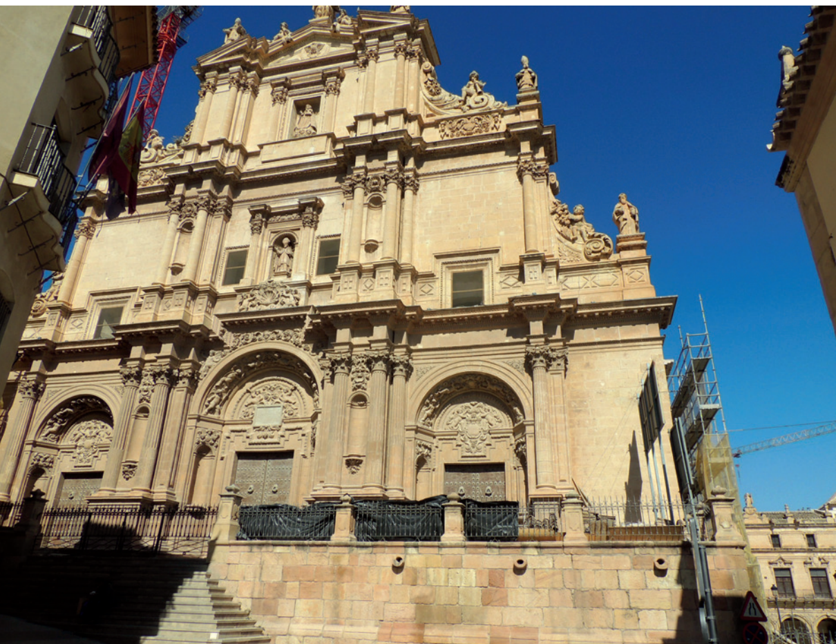
FIGURA 2: COLEGIATA DE SAN PATRICIO EN PROCESO DE REHABILITACIÓN TRAS LOS TERREMOTOS DE 2011
