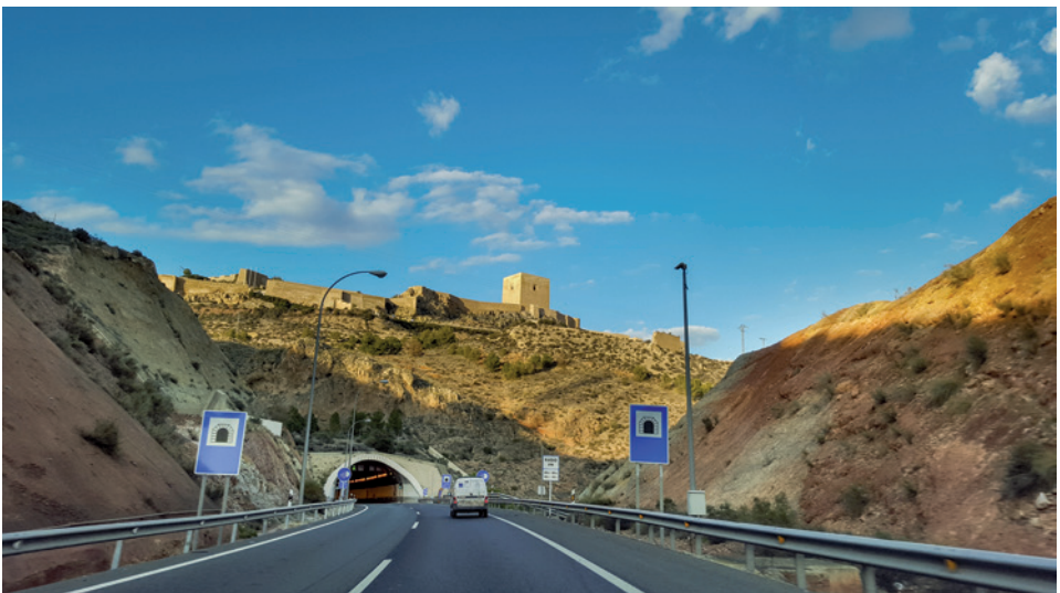
FIGURA 2: AUTOVÍA A-7 A SU PASO POR LORCA
