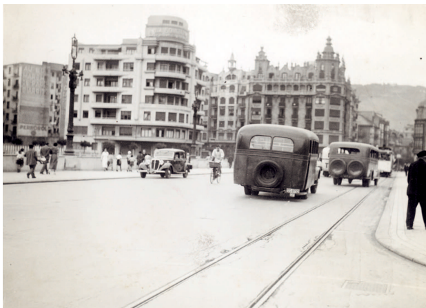
Uno de los primitivos autobuses de la línea de Donostia a Rentería fotografiado a su paso por el puente de Santa Catalina. Archivo EuskoTren/Museo Vasco del Ferrocarril.
