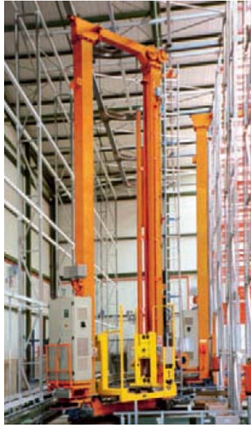
5.2.1.5 Detalle transelevador bicolumna en operación de cambio de pasillo
