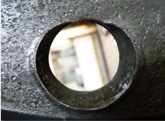
Stud hole deformation
