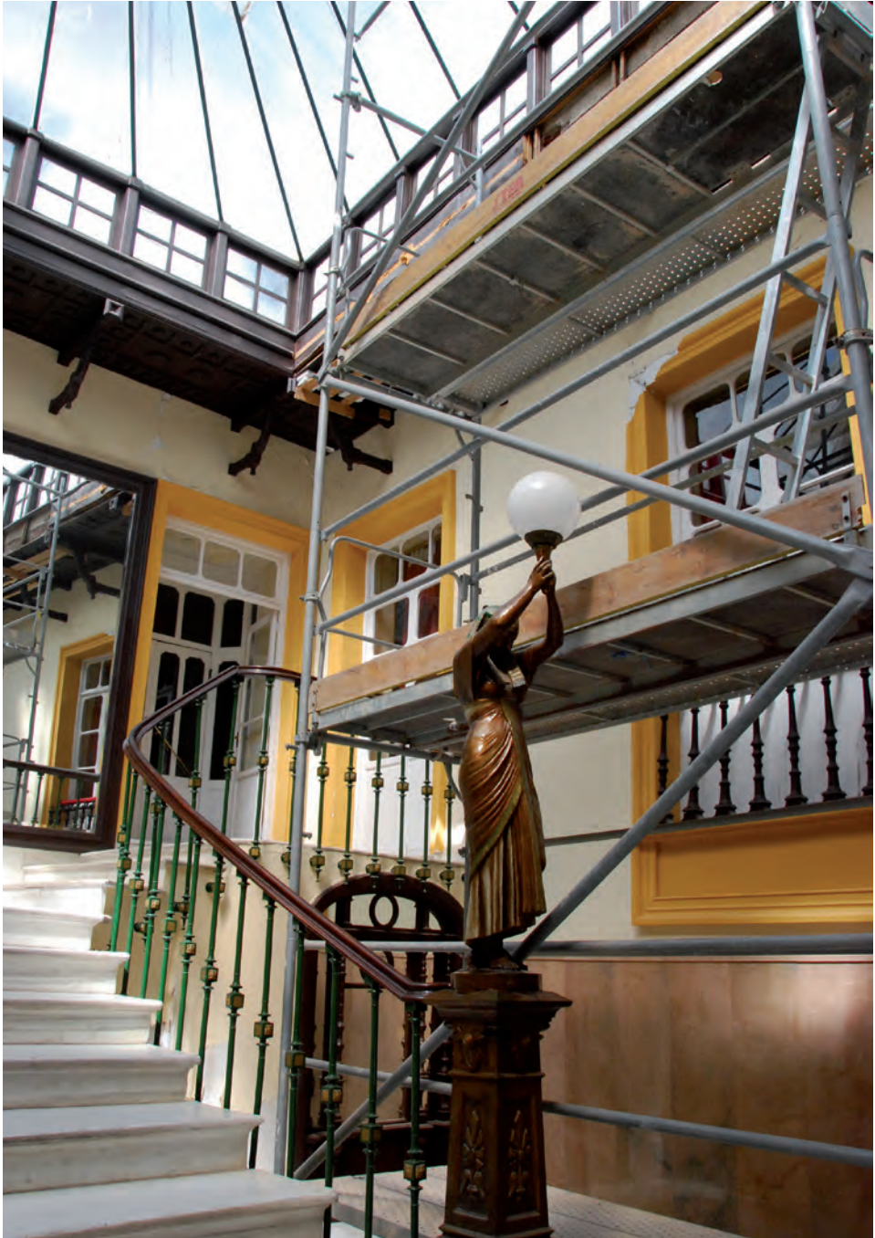
FIGURA 15. DAÑOS OCASIONADOS POR LOS SEÍSMOS
