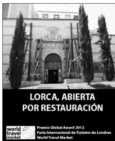
FIGURA 1: CARTEL LORCA ABIERTA POR RESTAURACIÓN
