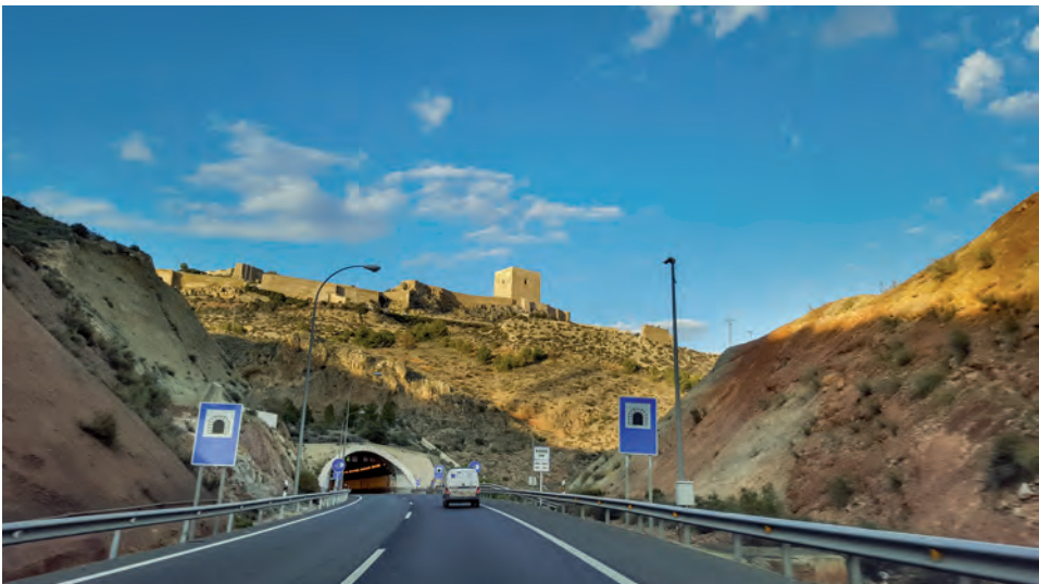
FIGURA 2: AUTOVÍA A-7 A SU PASO POR LORCA
