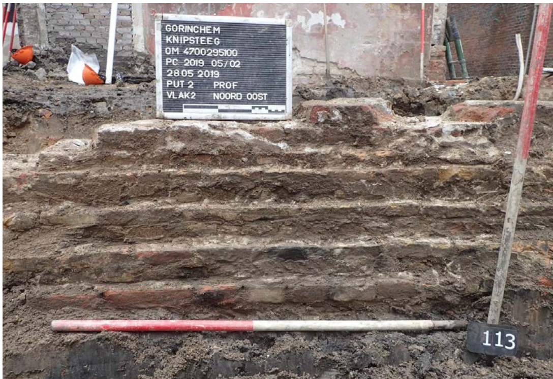
Figuur 29. Gorinchem, Knipsteeg 13-15: Westprofiel van spoor 113. Op basis van de type (kleur, afmetingen) bakstenen kunnen er drie fases worden herkend. De bovenzijde bestaat uit een (recente) baksteen muur met resten van een afgestreken specielaag. Deze muur was gefundeerd op een fundering bestaande uit 'kleine' gele bakstenen ( geeltjes of ijssel steentjes ) die weer gefundeerd waren een oudere fundering, bestaande uit grote kloostermoppen (onderste lagen, spoor 114).
