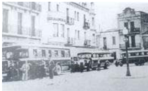
Terminal de la plaza de España de El Prat de Llobregat de la línea Barcelona-El Prat, de la empresa AUSA
