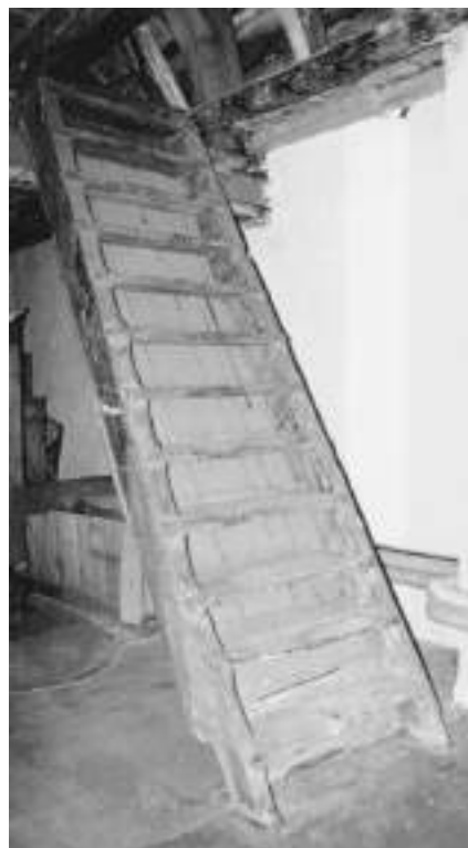
Laatmiddeleeuwse eikenhouten trap van de derde verdieping naar de zolder.
