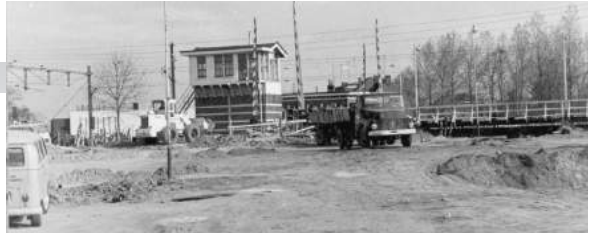
Werken aan de nieuwe tunnel.
