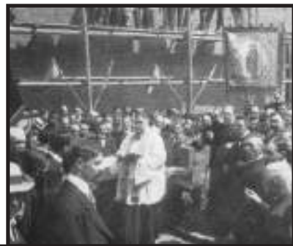
Eerste steenlegging van het Bondsgebouw 21 mei 1916. Bron: De Venlose K.A.B. in het Goud, 33.
