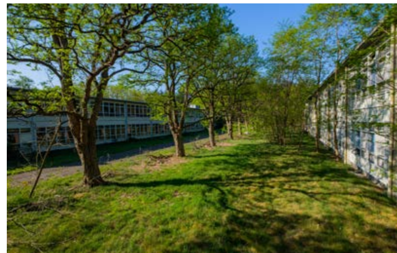
P257. Foto's entree en gebouw Wilhelminakazerne, Centraal Bouwbureau (C.B.B.) der Genie en E.F. Groosman (R. Zwinkels, 2020).
