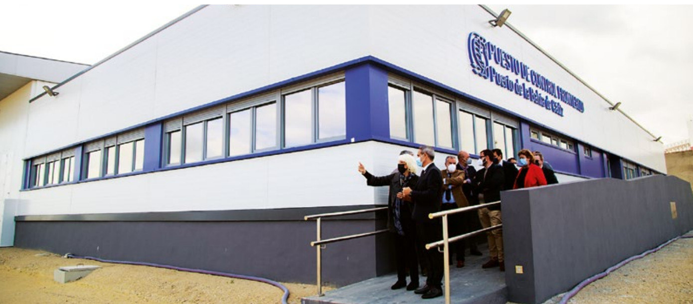
El proyecto del Puesto de Inspección Fronterizo es, junto a la nueva terminal de contenedores, uno de los proyectos más relevantes que está acometiendo la Autoridad Portuaria de la Bahía de Cádiz.
