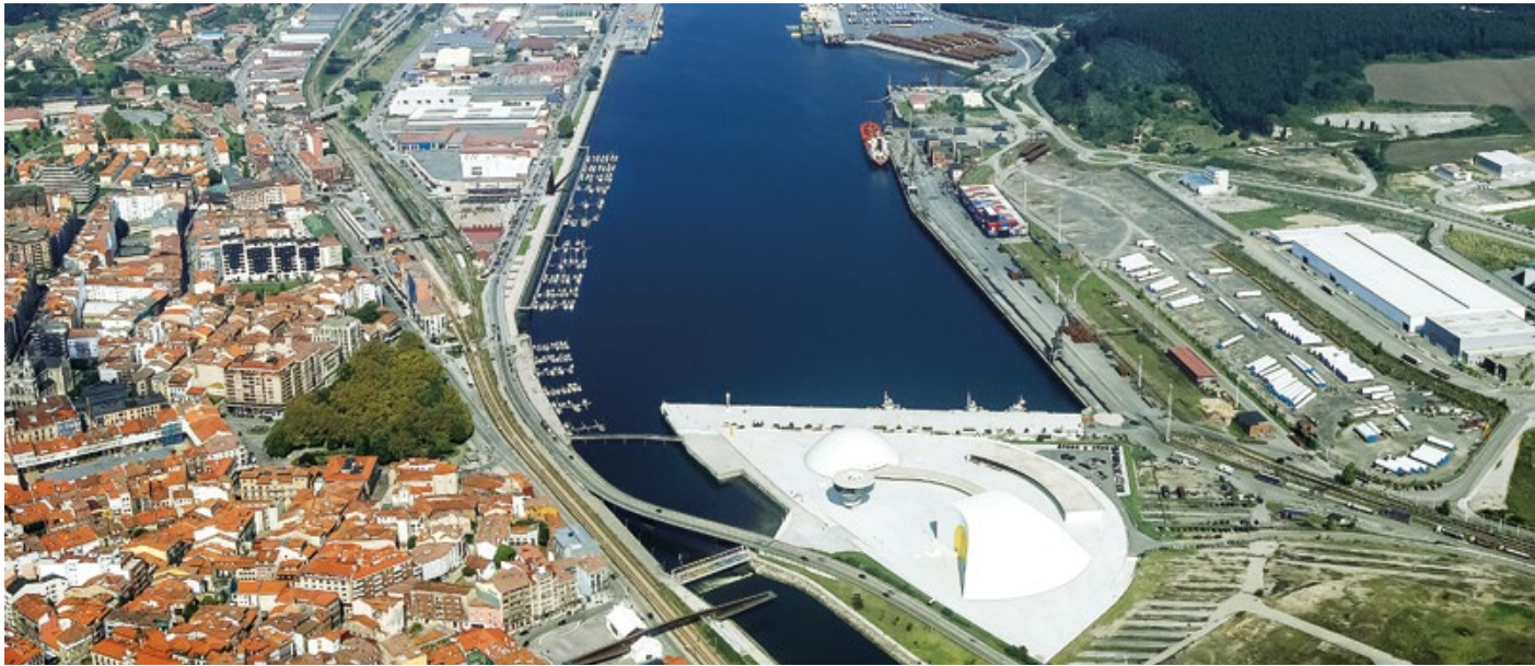
En el Plan de Inversiones destaca la ampliación del Muelle de Raíces y de la zona de servicios, con 11 millones de euros cada uno.
