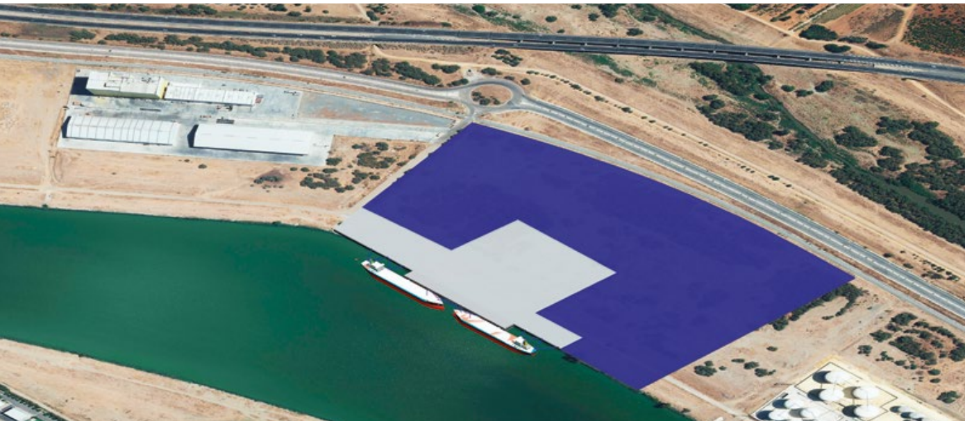
El Consejo de Administración de la Autoridad Portuaria de Sevilla adjudicó en 2021 a la empresa Aldeport la construcción y explotación de una nueva terminal multipropósito en el puerto andaluz, lo que potenciará la oferta y diversificación de sus tráficos.
