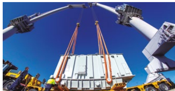
Sevitrade hizo historia en el Puerto de Sevilla al desarrollar la más compleja y numerosa operativa de transformadores eléctricos.
