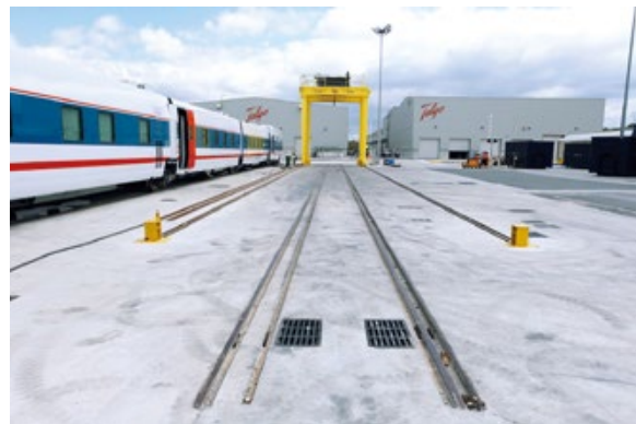
La planta de Talgo en Arasur se amplió en 7.000 metros cuadrados.
