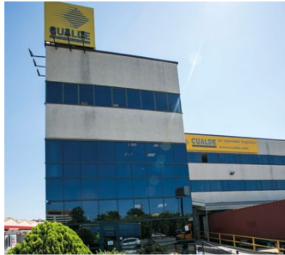
En su sede central, ubicada en Cornellá de Llobregat, Cualde Logistics cuenta con un almacén de 7.700 metros cuadrados.
