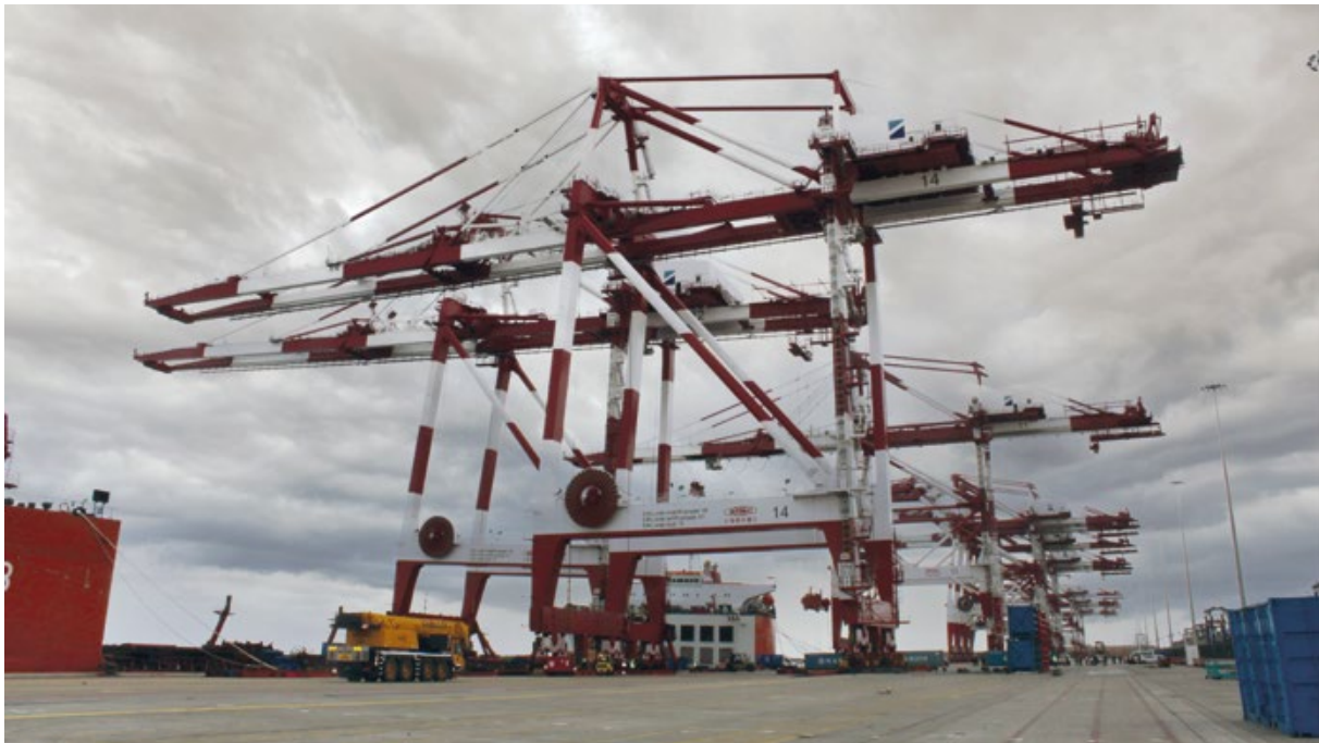
Las grúas adquiridas por BEST en marzo para su terminal en Barcelona tienen 47 metros de altura bajo spreader.
