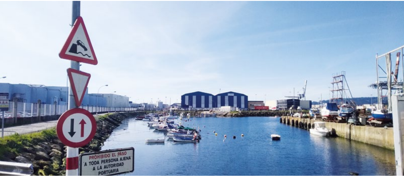
La Autoridad Portuaria de Marín y Ría de Pontevedra adjudicó en febrero las obras de remodelación de la Dársena de Placeres, una actuación para reforzar la integración Puerto-Ciudad y en la que se invertirá 800.000 euros.
