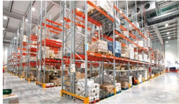
AR Racking equipó la plataforma logística de Caprabo en la ZAL con un sistema de paletización convencional que incorpora varios niveles de picking.
