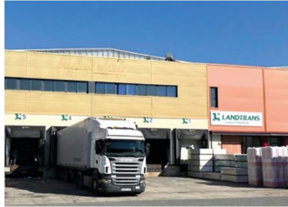
Almacén logístico y aduanero de Landtrans en la ZAL de Sevilla.
