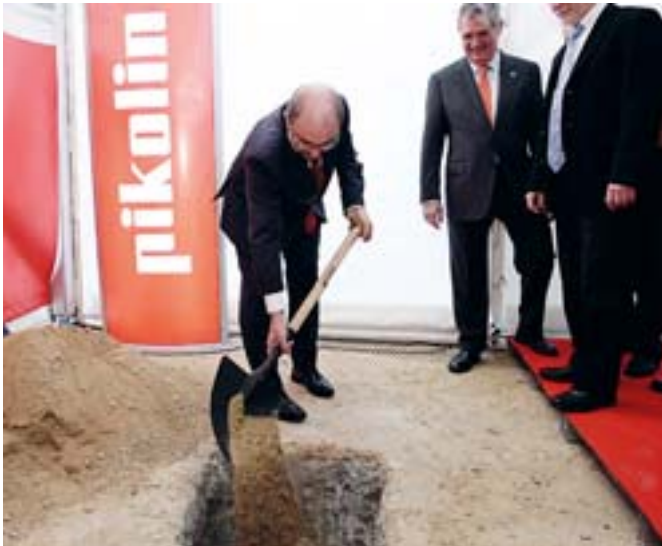
El presidente de Aragón, Javier Lambán, colocó la primera piedra de las nuevas instalaciones de Pikolin en PLAZA.
