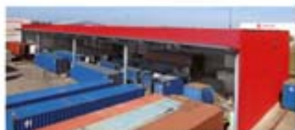
REPARACIÓN Y LIMPIEZA
