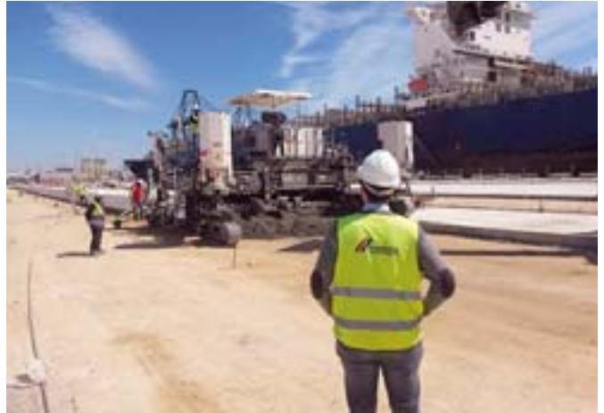
CEMEX participó en la pavimentación de 90.000 metros cuadrados en la terminal pública de contenedores del puerto de Valencia.
