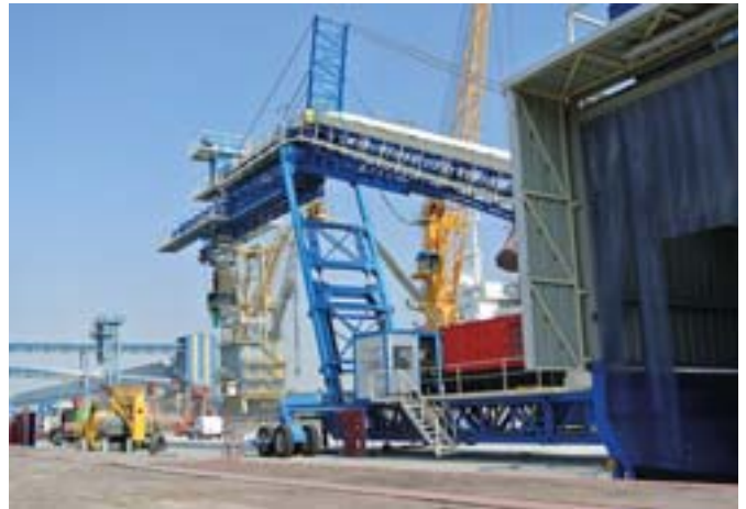
Instalaciones de Temagra en el Muelle Sur del Puerto de Valencia.
