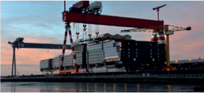
El "Symphony of the Seas" en construcción.
