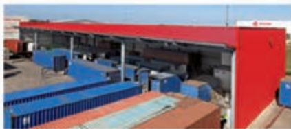
REPARACIÓN Y LIMPIEZA
