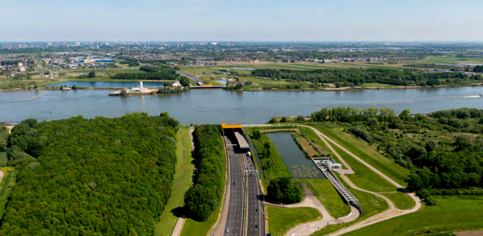
Renovation Heinenoordtunnel, A29 Barendrecht.
