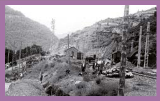
Construcción del nuevo ferrocarril en la estación de Ribes-Enlase. Archivo Salmerón (1928).
