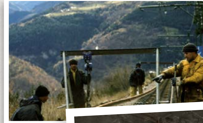
Renovación de las vías entre Queralbs y Núria. Archivo FGC (1998).
