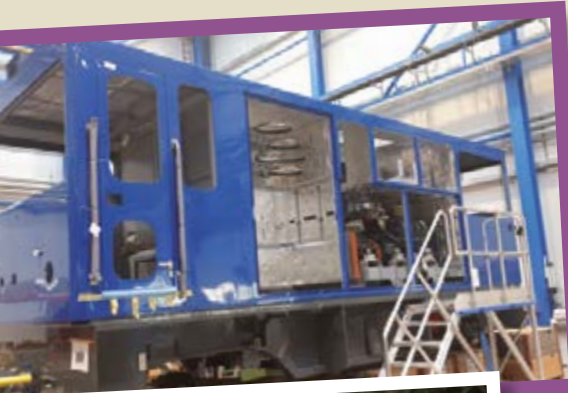
Construcción de la locomotora H12 en la factoría Stadler de Suiza. Foto T. Anton Archivo FGC (2019).
