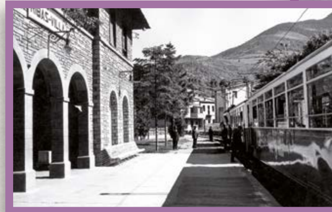
A finales de los años setenta y principios de los ochenta el Cremallera vivió una época de decadencia. Archivo FGC (c1970).
