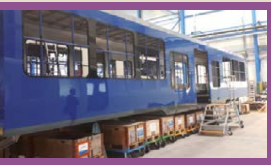
Construcción de los nuevos remolques en la factoría Stadler. Foto T. Anton Arxiu FGC (2019).
