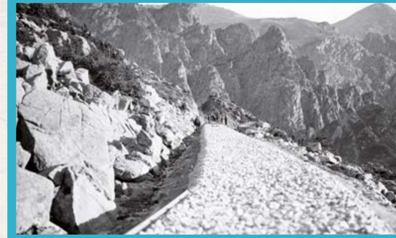
Construcció del traçat a la sortida de Queralbs. Arxiu Salmerón (1930).
