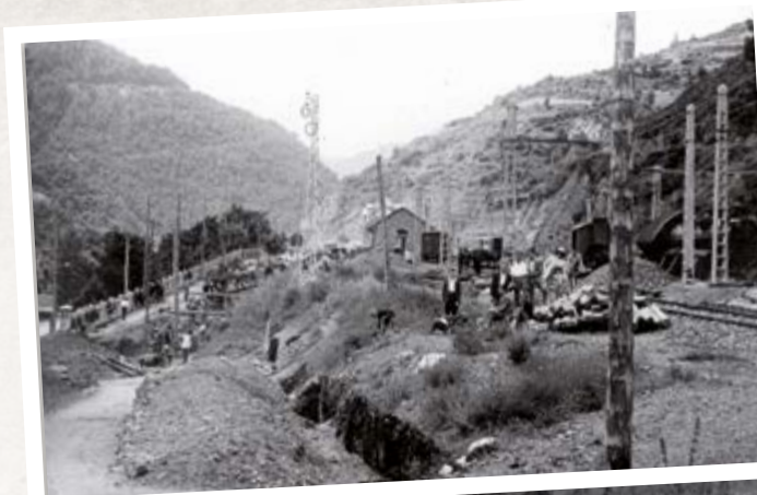
Construcció de l'estació d'enllaç entre el Cremallera i el Ferrocarril Transpirinenc. Arxiu FGC (1928).
