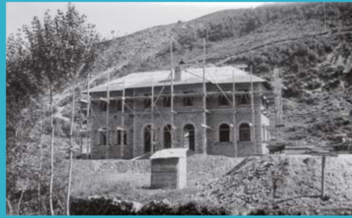
Construcció de l'estació de Ribes-Vila. Arxiu FGC (1930).
