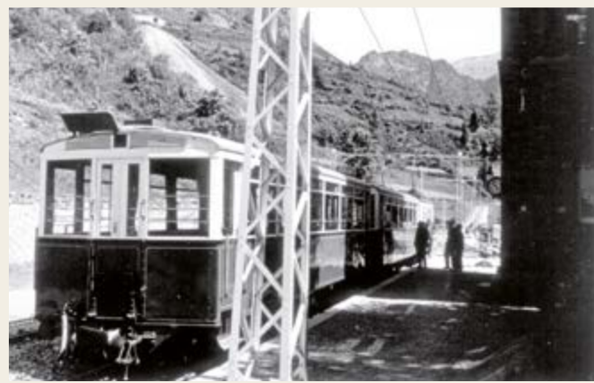
L'estació de Queralbs s'utilitzava com a principal lloc de creuament dels trens ascendents i descendents. Arxiu FGC (c1960).
