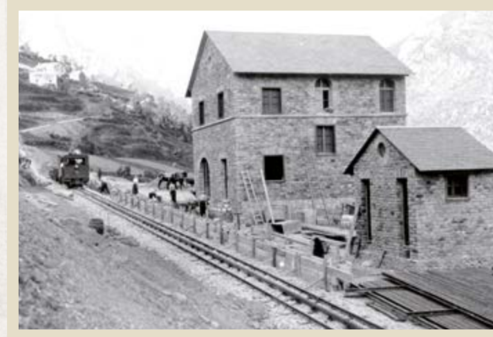
La locomotora núm. 6, amb un tren de treballs, a l'estació de Queralbs. Arxiu FGC (1930).
