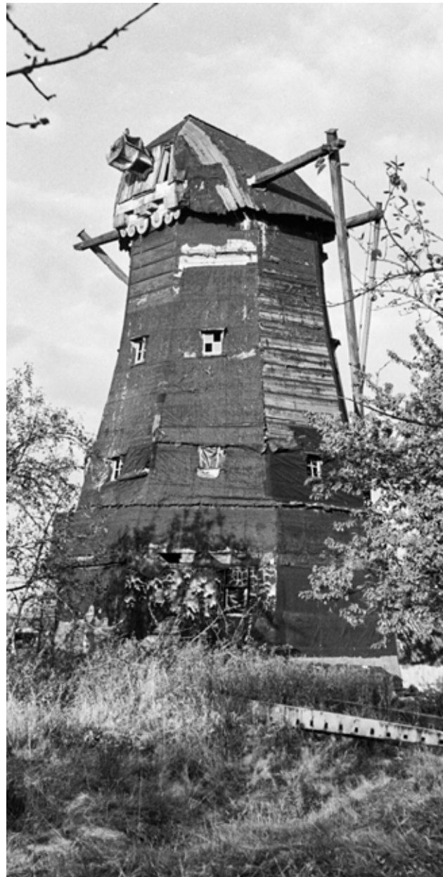
De door de gemeente gekochte molen wordt veiligheidshalve van de wieken ontdaan in afwachting van de restauratie. Op de voorgrond liggen de oude potroeden
