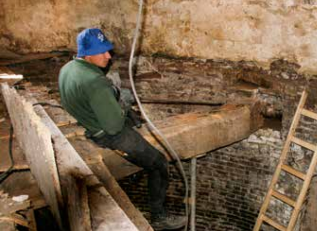
Draagbalk wordt gerestaureerd met epoxyhars en glasfiber.
