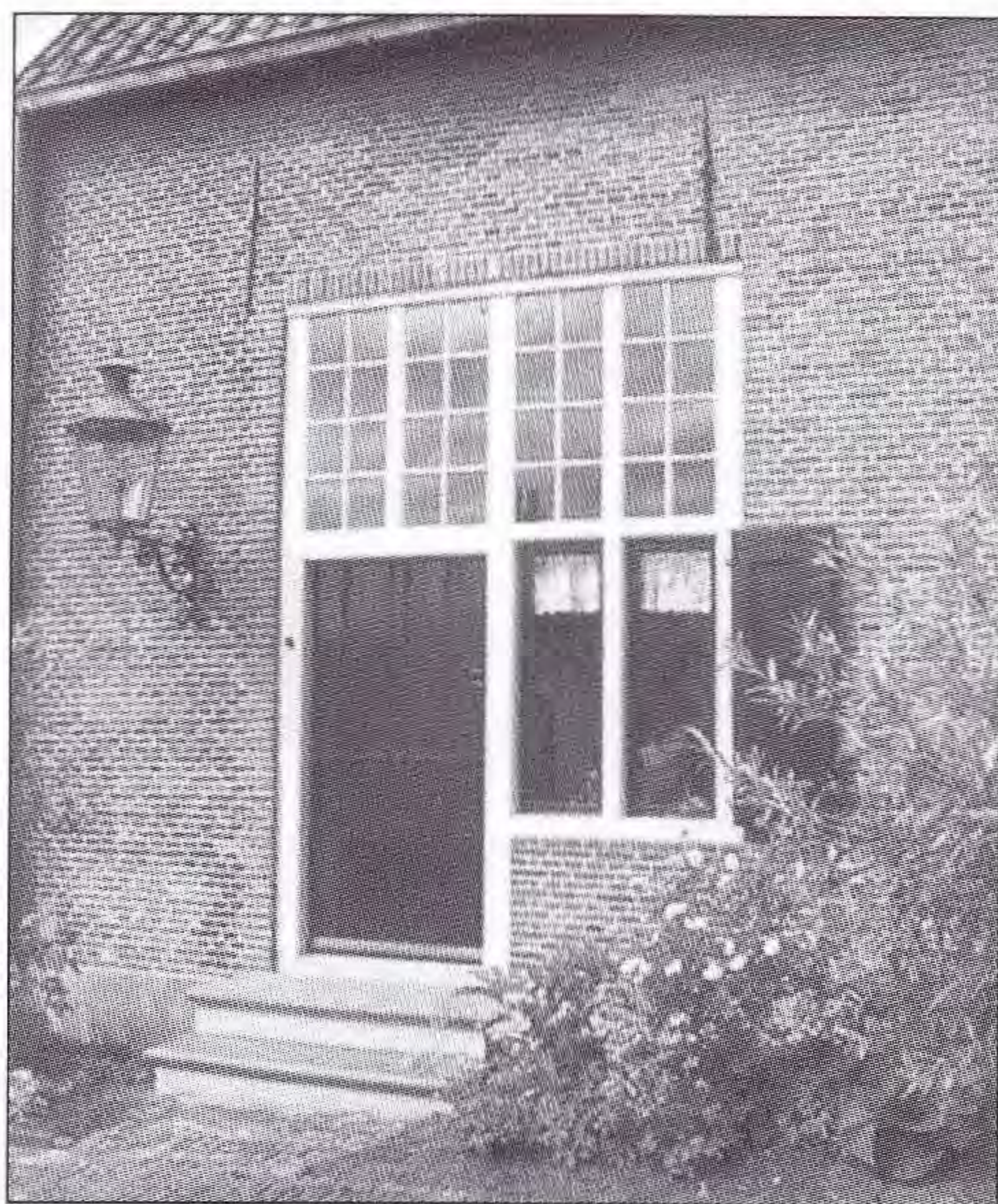
Afb. G4 Kruiskozijn in de gerestaureerde zijgevel, deur met raam aan één kant (half melkmeisje).
