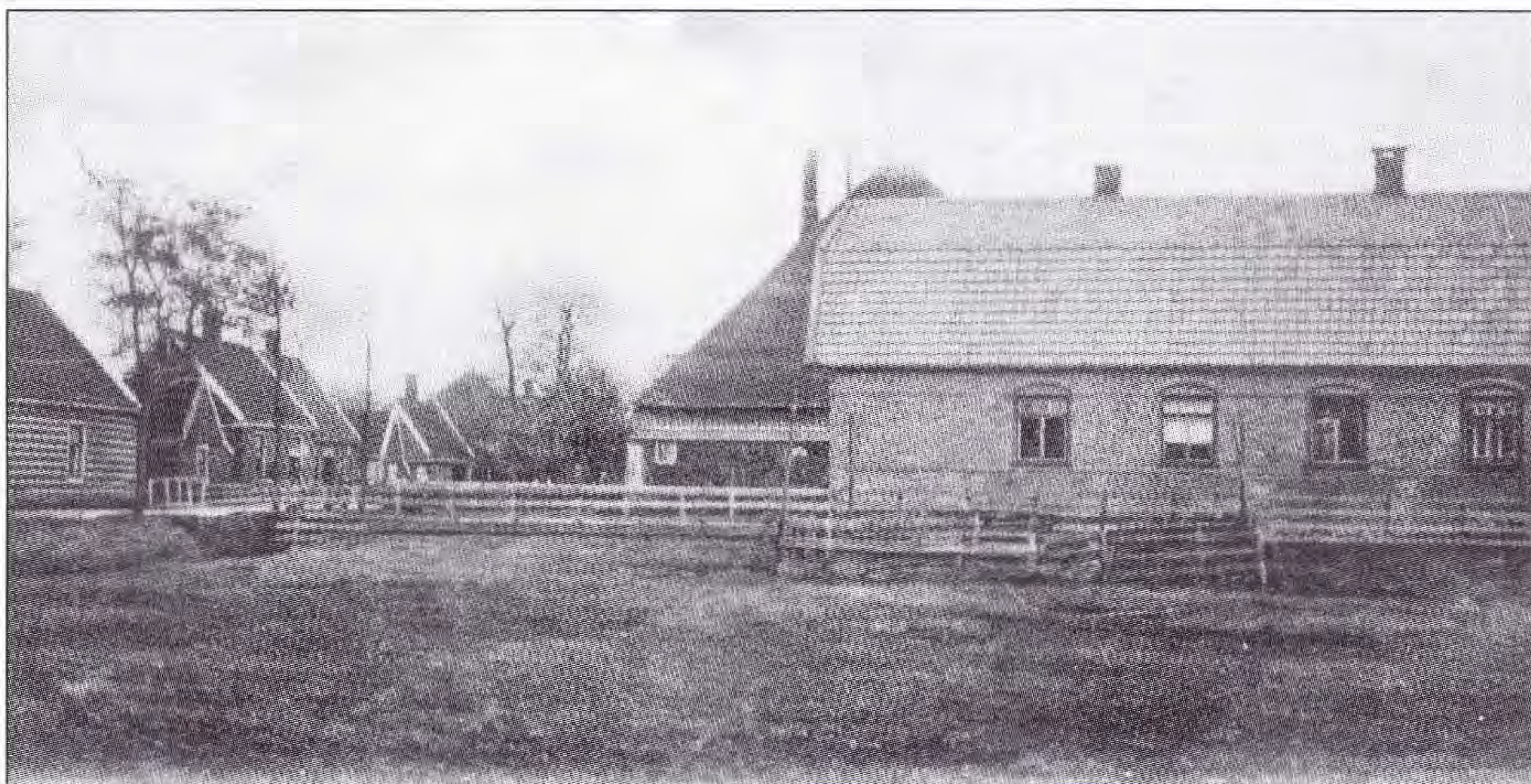
Kaas- en zuivelfabriek "Wilhelmina", Berkhout begin 20e eeuw.
