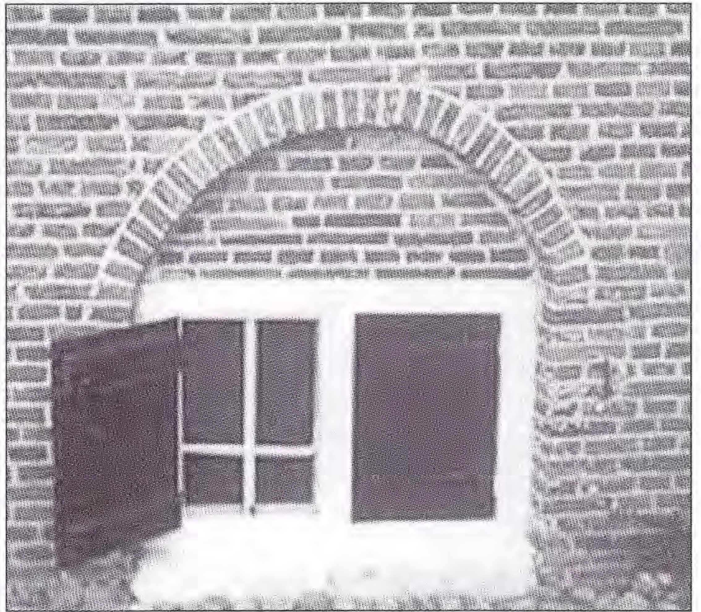
Afb. A1 Ontlastingsboog boven het oudste kelderraam van " Dorpzicht ".
