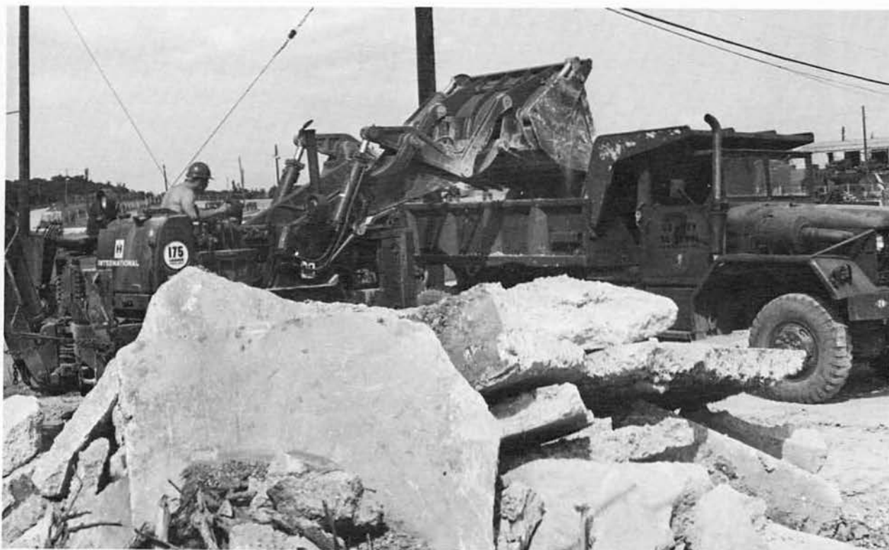
EO3 G. Westin dumps the remains of the EM Club
