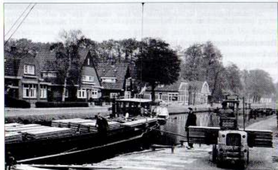
Moerheimstraat. Op de achtergrond de "brug van Luuks Koiter".
