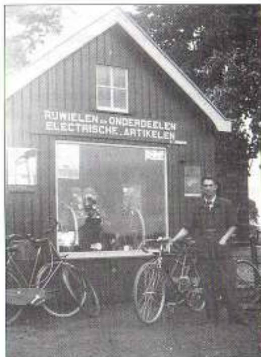
De werkplaats naast de openbare lagere school aan Sluis 6.
