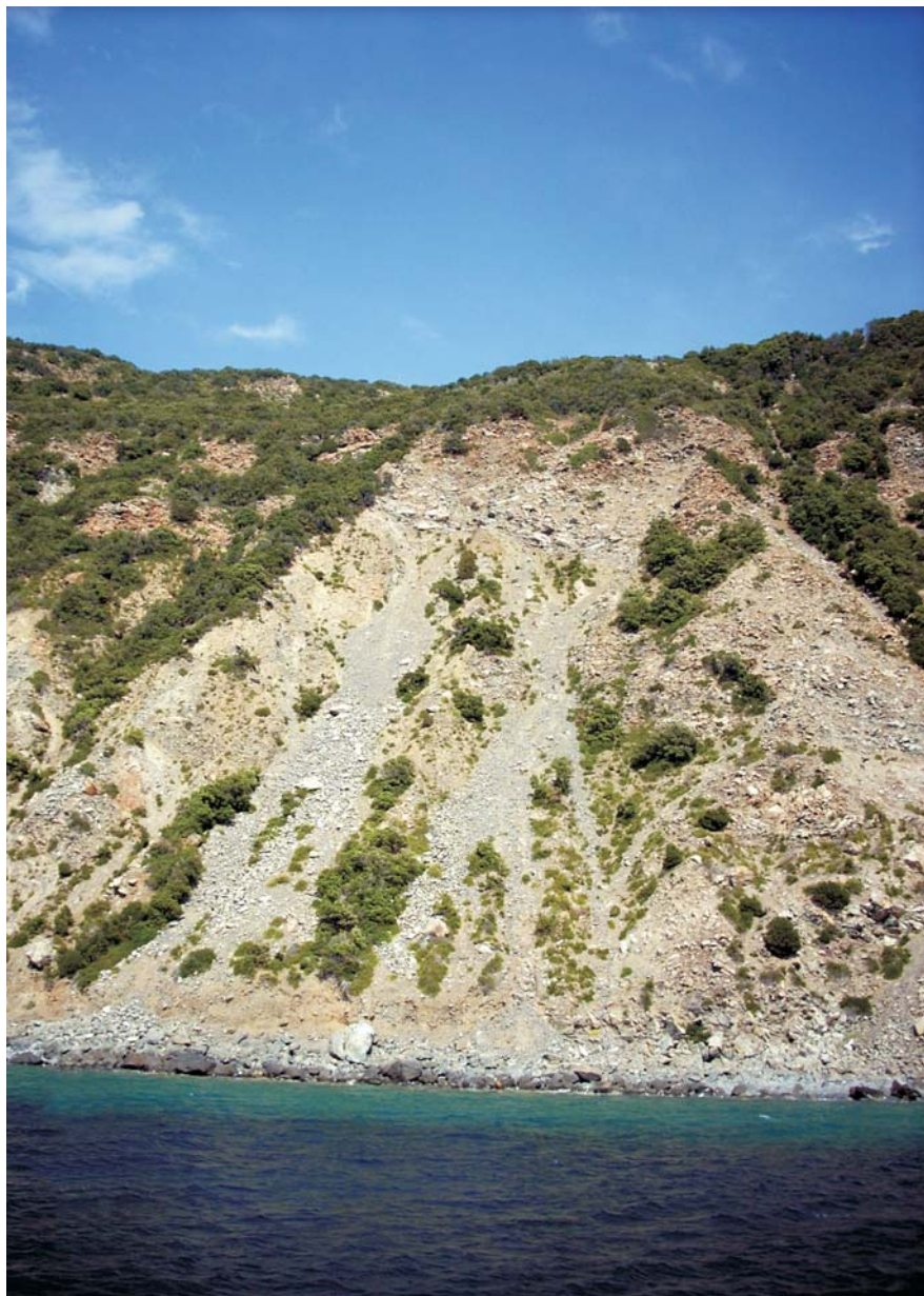
Fig. 30 - Tratto di costa tra punta del Timone e punta della Fornace (M. Capanne occidentale), soggetto a fenomeni franosi di scorrimento rotazionale.
