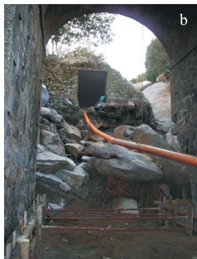
Fig. 126 - Residenza turistico alberghiera le Caviere dopo l'evento alluvionale del 7 novembre 2011: a) parcheggio auto distrutto dalla piena del fosso Stabbiati; b) tratto di fosso intubato per la costruzione del soprastante parcheggio.
