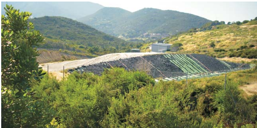
Fig. 113 - Discarica per lo stoccaggio di rifiuti urbani nella valle a nord di monte Bacile (comune di Campo nell'Elba).
