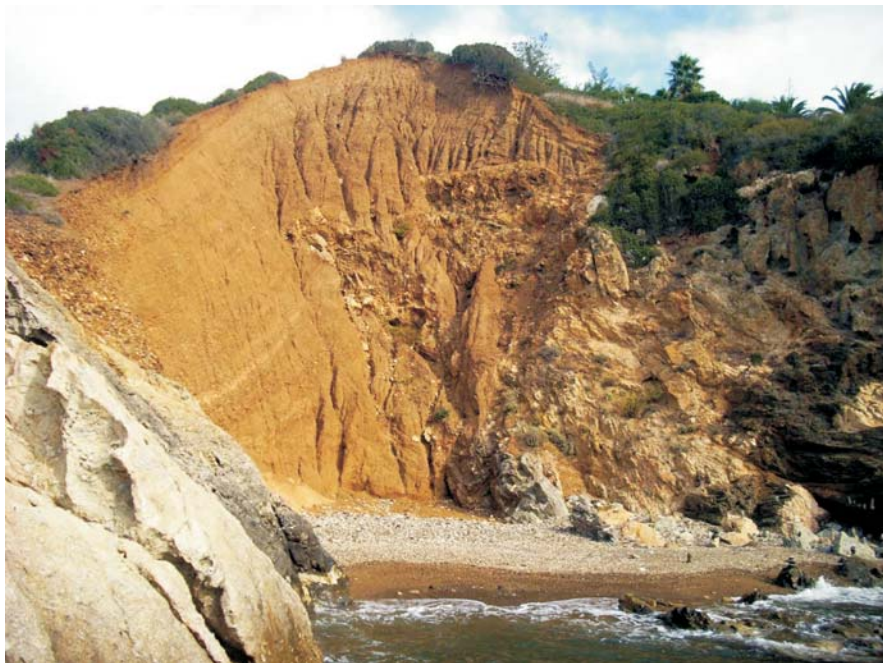
Fig. 29 - Nicchia di frana prevalentemente di scorrimento rotazionale, situata tra la spiaggia di Barbarossa e Capo Bianco. Il fenomeno franoso è stato innescato dallo scalzamento al piede di depositi di discarica mineraria da parte della dinamica marina.
