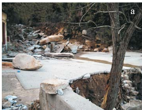
Fig. 126 - Residenza turistico alberghiera le Caviere dopo l'evento alluvionale del 7 novembre 2011: a) parcheggio auto distrutto dalla piena del fosso Stabbiati; b) tratto di fosso intubato per la costruzione del soprastante parcheggio.
