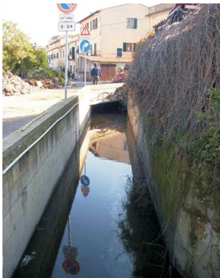
Fig. 118 - Fosso proveniente dalla località Albarelli a lato di via G. Fattori, nel centro abitato di Marina di Campo. La sezione del fosso è stata ridotta e l'ultimo tratto tombato per consentire il sottoattraversamento dell'area urbana.
