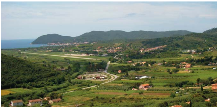
Fig. 51 - Piana alluvionale nel territorio di Campo nell'Elba, percorsa dai fossi Galeo e della Pila, che sfociano nel golfo di Campo. Tra i due fossi è stata realizzata la pista dell'aeroporto di Marina di Campo (a sinistra della foto).
