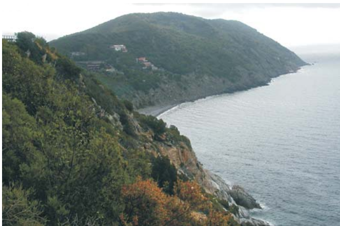
Fig. 69 - Tratto di costa subrettilineo tra punta di Cavoli e capo di Poro interessato, peraltro, da numerosi fenomeni franosi.
