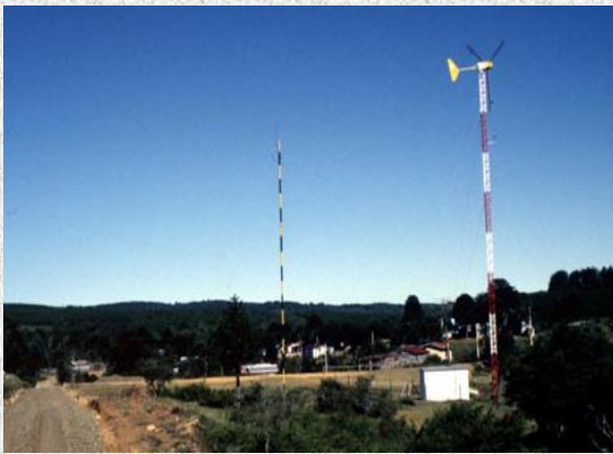
7-kW Turbine in Villa Las Araucarias
