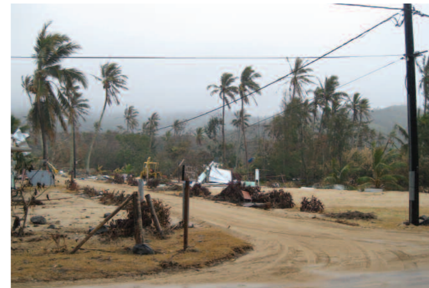
PHOTO 2 Dégâts générés à Tubuai par la marée de tempête et la surcote générées par le cyclone Oli en 2010. L'île a été recouverte de sables. © Moana Mariassouce
