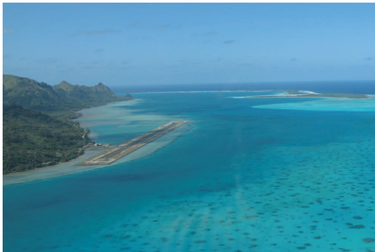
Lagon de Raivavae et remblai aménagé pour la construction de l'aérodrome. © CRIOBE
