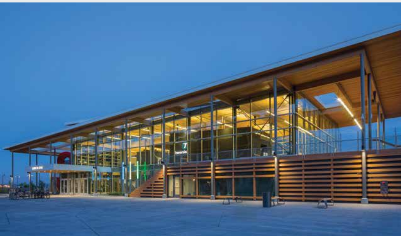
▲ Gare Fluviale de Lévis, Lévis, QC LoE 366 Insulating Glass Units GLCRM architectes Photo: Stéphane Groleau
