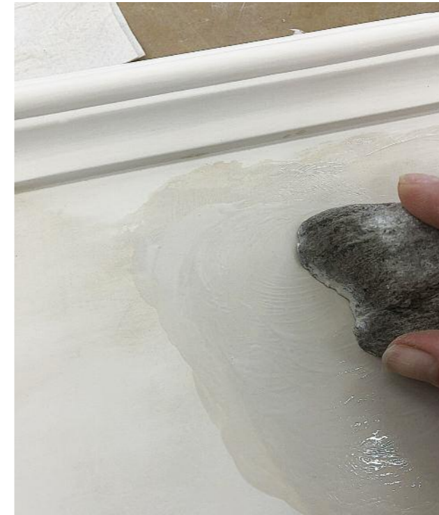
6 Aufschlätzen und Schleifen der Grundierung mit Bimsstein
