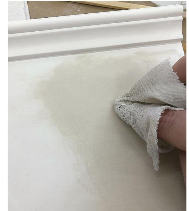
7 Abziehen der Kreidegrundschlämme mit einem Baumwolltuch
