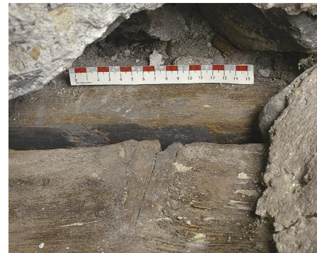
6 Detailansicht einer Deckenbohle von oben mit schwarzem Anstrich
