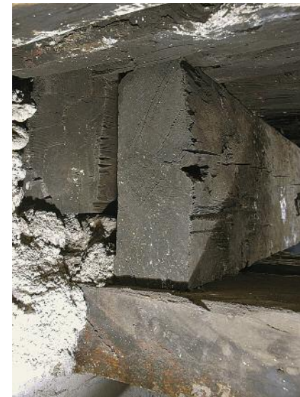
5 Detailansicht der Stirnseiten der Balken mit schwarzem Anstrich
