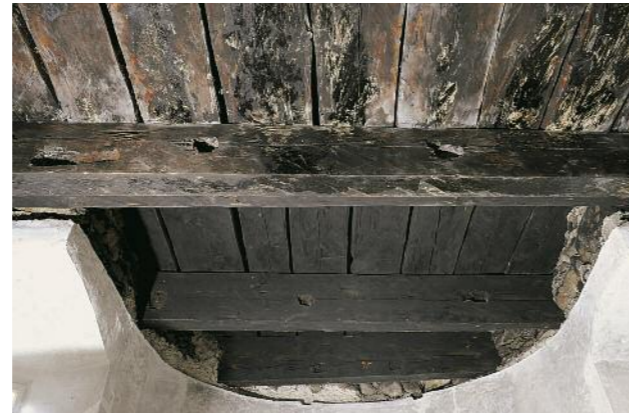
7 Ausnehmungen an Balken der Decke über der Apsis mit bisher unbekannter Funktion
