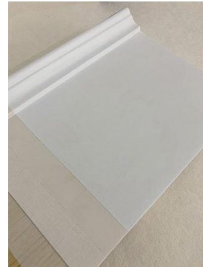
10 Ausreichend glatte Oberfläche nach erneutem Schleifen mit Farbunterschied zwischen der gelblich wirkenden Grundierung und dem gebrochenen Weißanstrich
