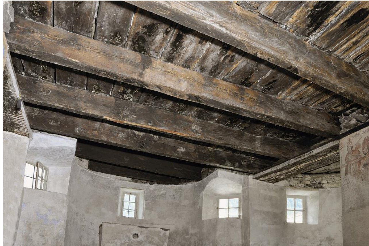
2 Untergeschoss der Kapelle mit Sicht auf die Decke Richtung Apsis
