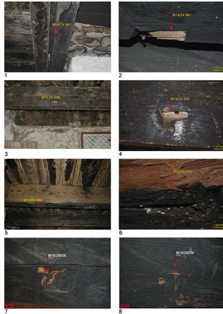
10 (1 bis 6) Entnahmestellen der Proben von 2014 und 2016 – M14/2458 bis M14/2461 in der Übersicht und im Detail und M16/25038 und M16/25039 im Detail
