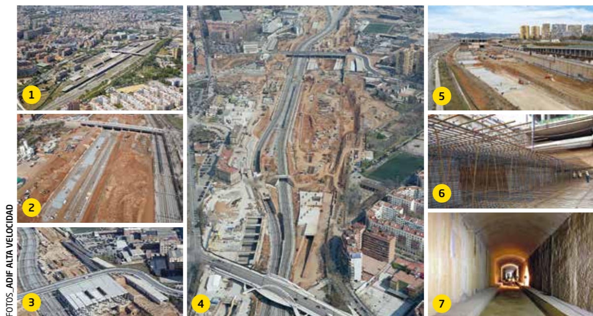
1. Antigua terminal de mercancías de La Sagrera (2007). 2. Construcción del trazado provisional (2008). 3. Inicio de la construcción de la zona logística (2013). 4. Inicio de la excavación entre pantallas (2012). 5. Inicio de la construcción de la losa de fondo (2018). 6. Detalle del armado de la losa de fondo (2018). 7. Tramo de colector de la rambla Prim finalizado (2018).
