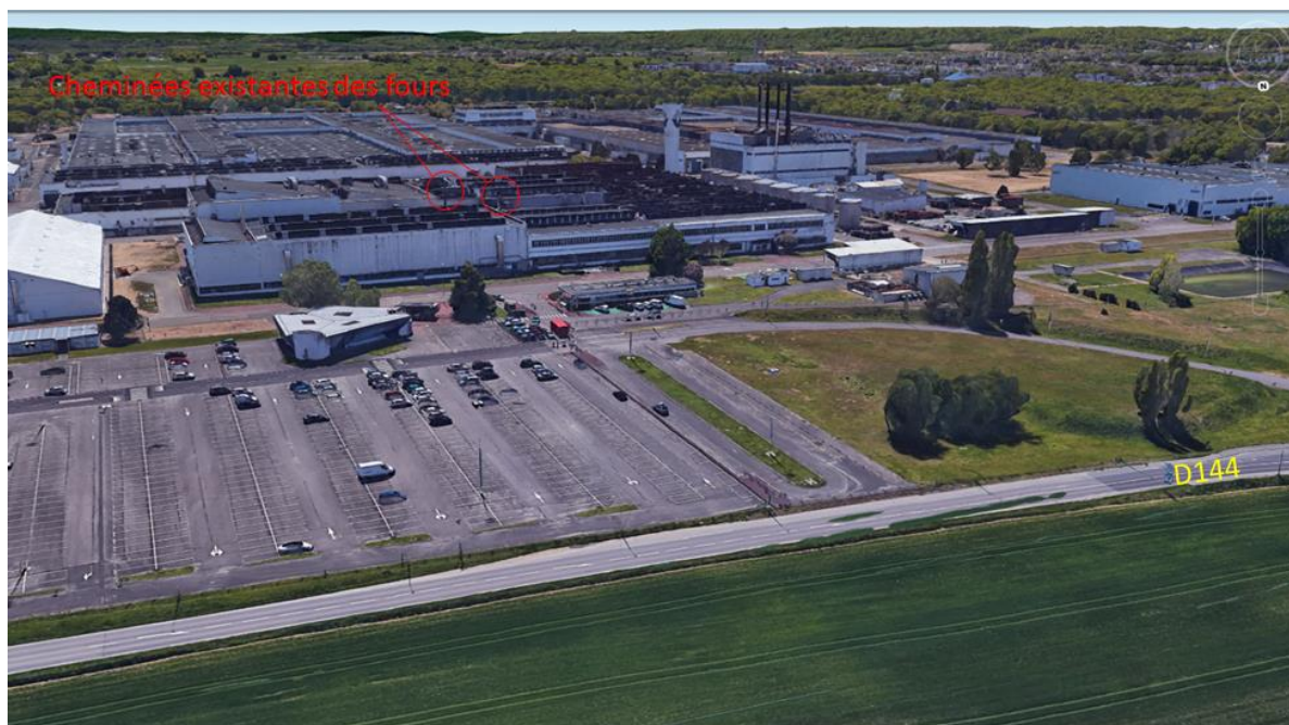
Figure 37 : Vue aérienne du bâtiment J depuis le nord du site (source : googleearth)
