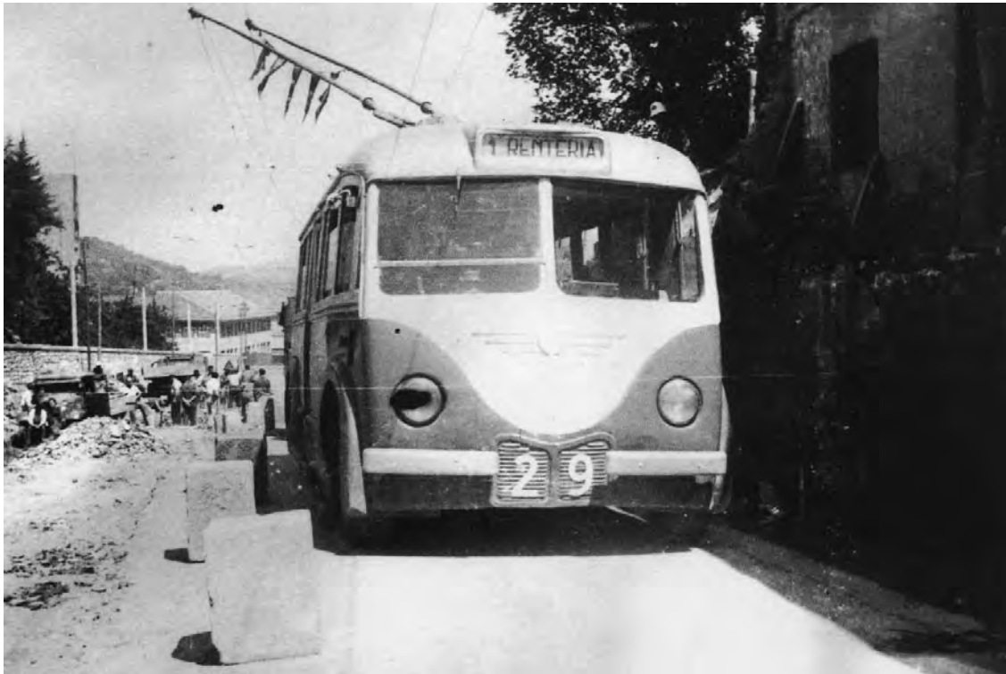
Imagen nº 59: Trolebús BUT, carrozado por Seida a su paso por el alto de Miracrúz. Se aprecian las obras en la carretera N-1. Las mejoras realizadas en esta calzada dificultaron la explotación del servicio de trolebuses a Rentería. Archivo Fototeca Kutxa.
