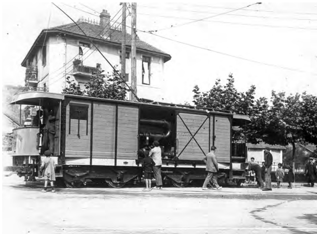
Imagen nº 44: En 1932 la Compañía del Tranvía de San Sebastián adquirió de ocasión a la Diputación Provincial dos furgones automotores para riego de carreteras con el fin de aprovechar sus equipos como repuestos. Archivo del Museo Vasco del Ferrocarril.
