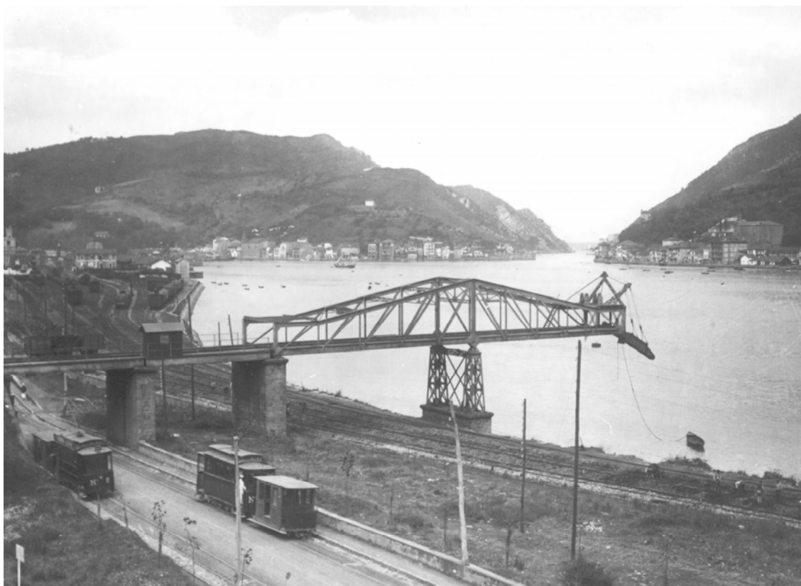
Imagen nº 31: En 1908 la doble vía se extendió hasta Rentería. En la fotografía, paso de dos tranvías bajo el cargadero sistema Cantilever del ferrocarril de Arditurri en Pasajes. Archivo del Museo Vasco del Ferrocarril.
