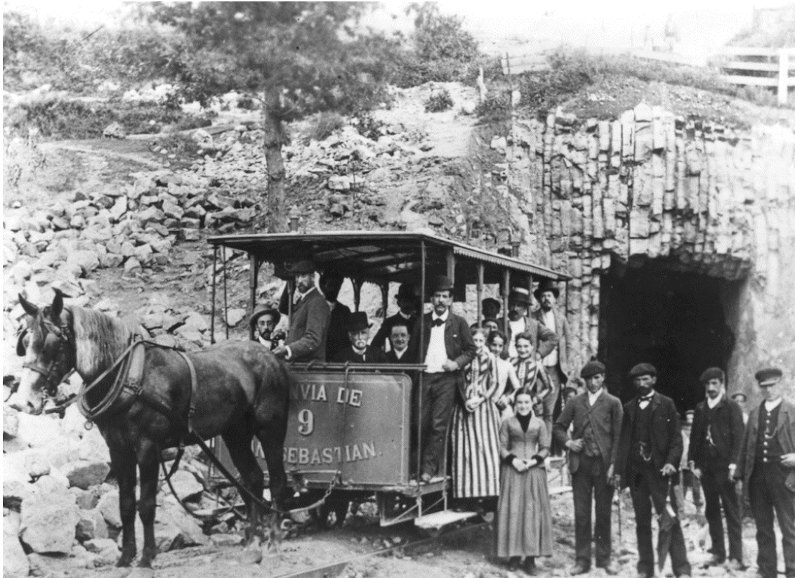
Imagen nº 11: La perforación del túnel de Herrera permitió prolongar la línea del tranvía hasta Pasajes Ancho. Archivo del Museo Vasco del Ferrocarril.
