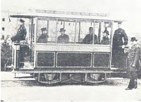
Imagen nº 6: Primer prototipo de tranvía eléctrico de Siemens. Archivo de William D. Middleton
