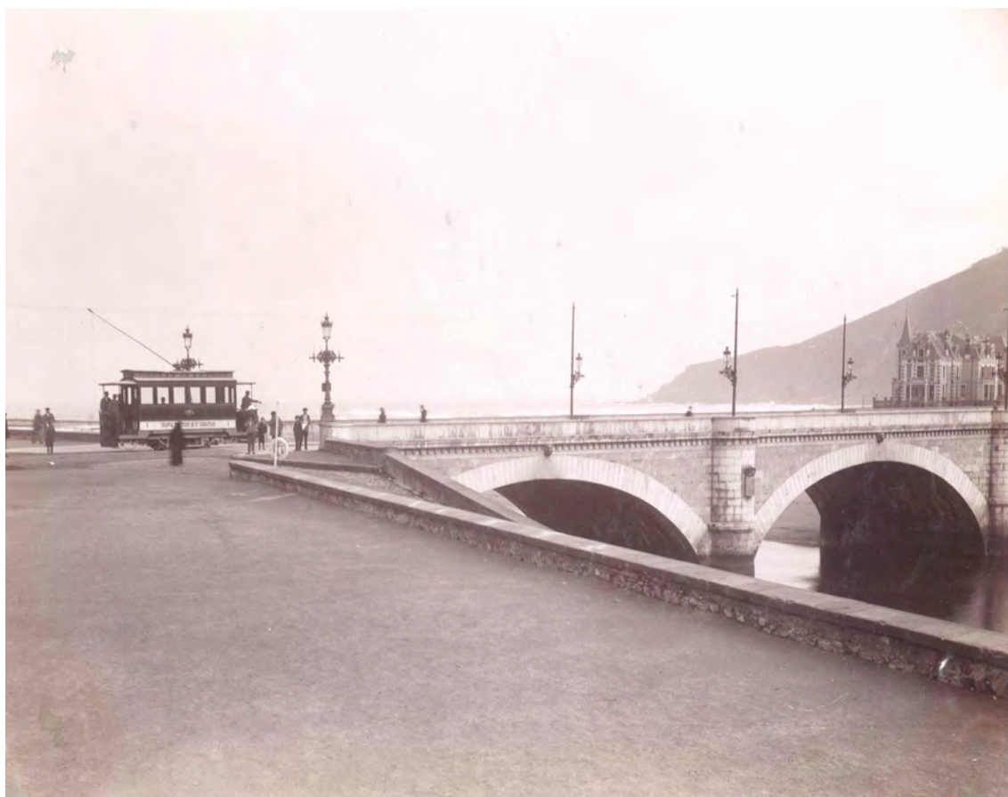
Imagen nº 19: El 29 de octubre de 1897 quedó completada la electrificación del tranvía de San Sebastián. En la imagen, uno de los coches suministrados por Sécheron a su paso por el puente de Santa Catalina, en dirección a Rentería. Archivo del Museo Vasco del Ferrocarril. Fondo, Compañía del Tranvía de San Sebastián. Expediente Nº 6.
