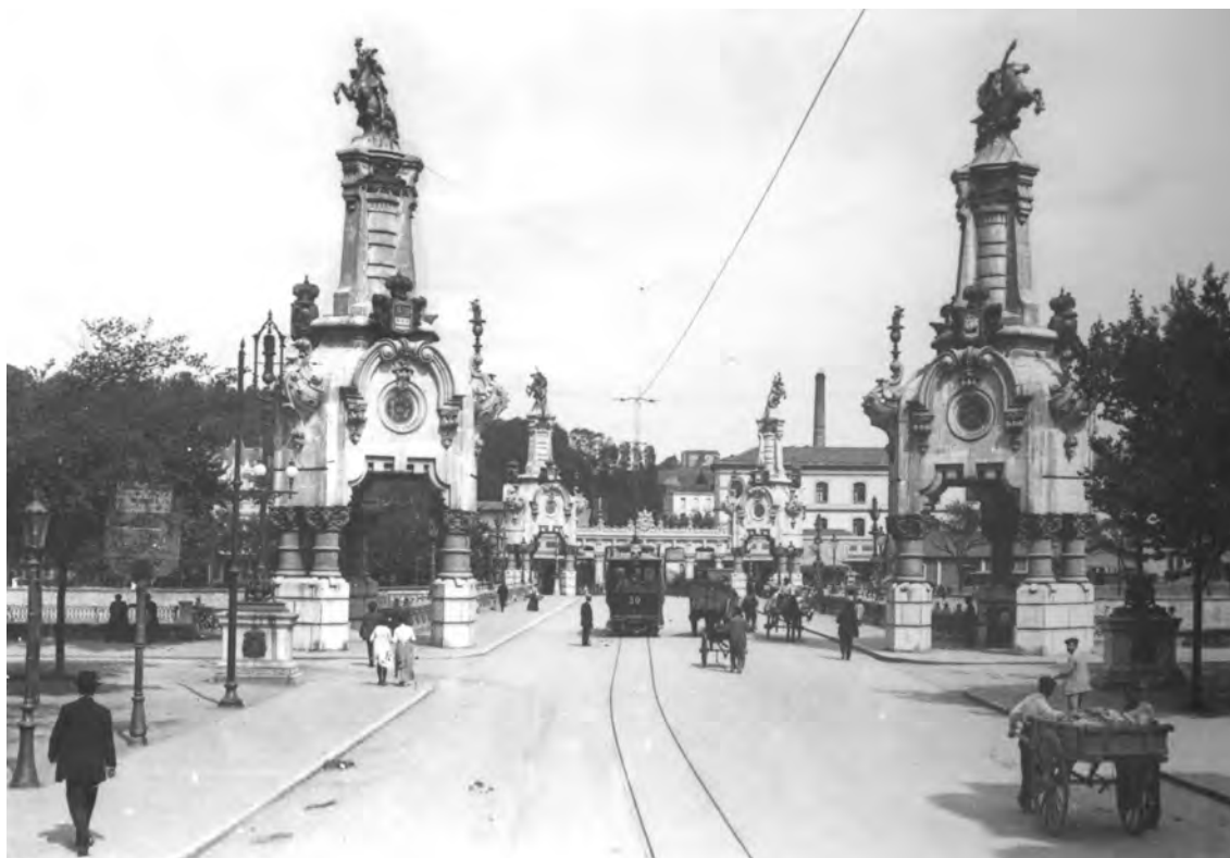
Imagen nº 29: La construcción del puente de Maria Cristina permitió establecer una nueva línea a la estación del Norte. Archivo del Museo Vasco del Ferrocarril.
