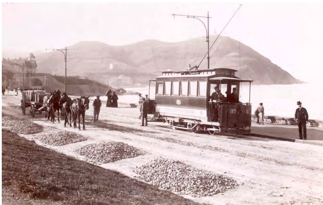
Imagen nº 88: La electrificación del tranvía mediante línea aérea de alimentación fue un indudable acierto tecnológico pese a los inconvenientes que acarreó su precocidad. Archivo del Museo Vasco del Ferrocarril.
