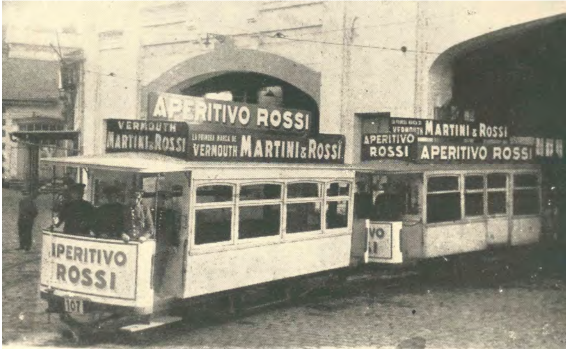
Imagen nº 35: Dos modelos de remolques de la Compañía del Tranvía de San Sebastián, fotografiados en las cocheras de Ategorrieta. Se aprecia en el de la derecha la puerta del furgón para transporte de paquetería. Archivo del Museo Vasco del Ferrocarril.
