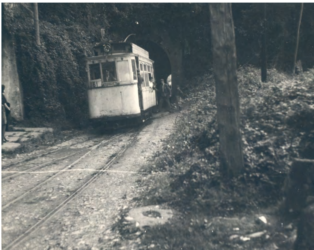
Imagen nº 57: El último servicio de tranvías de San Sebastián funcionó hasta julio de 1958 en el tramo de explanación propia comprendido entre Ategorrieta y Herrera. La caída del techo de la cochera en la que se guardaban los vehículos asignados a este trayecto precipitó la desaparición de los últimos tranvías de la capital guipuzcoana. Archivo del Museo Vasco del Ferrocarril.
