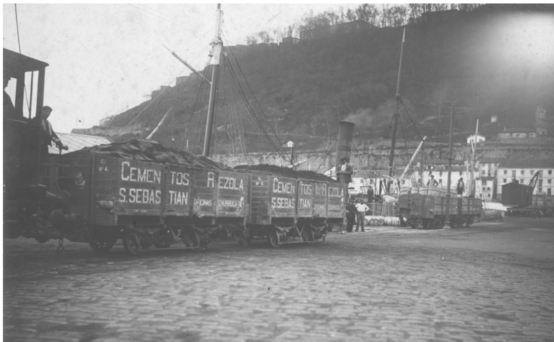
Imagen nº 87: Los servicios de carga de la Compañía del Tranvía facilitaron el desarrollo de diversos tráficó de mercancías en el histórico puerto donostiarra y el mantenimiento de su actividad comercial en detrimento del nuevo puerto de Pasajes. Archivo del Museo Vasco del Ferrocarril.
