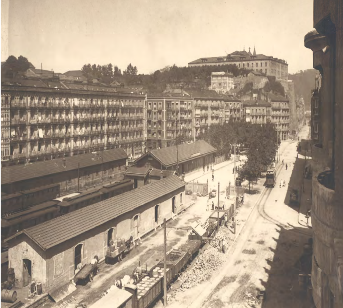
Imagen nº 28: en 1903 se inauguró la línea de tranvías a la estación de Amara. Archivo Museo Vasco del Ferrocarril.
