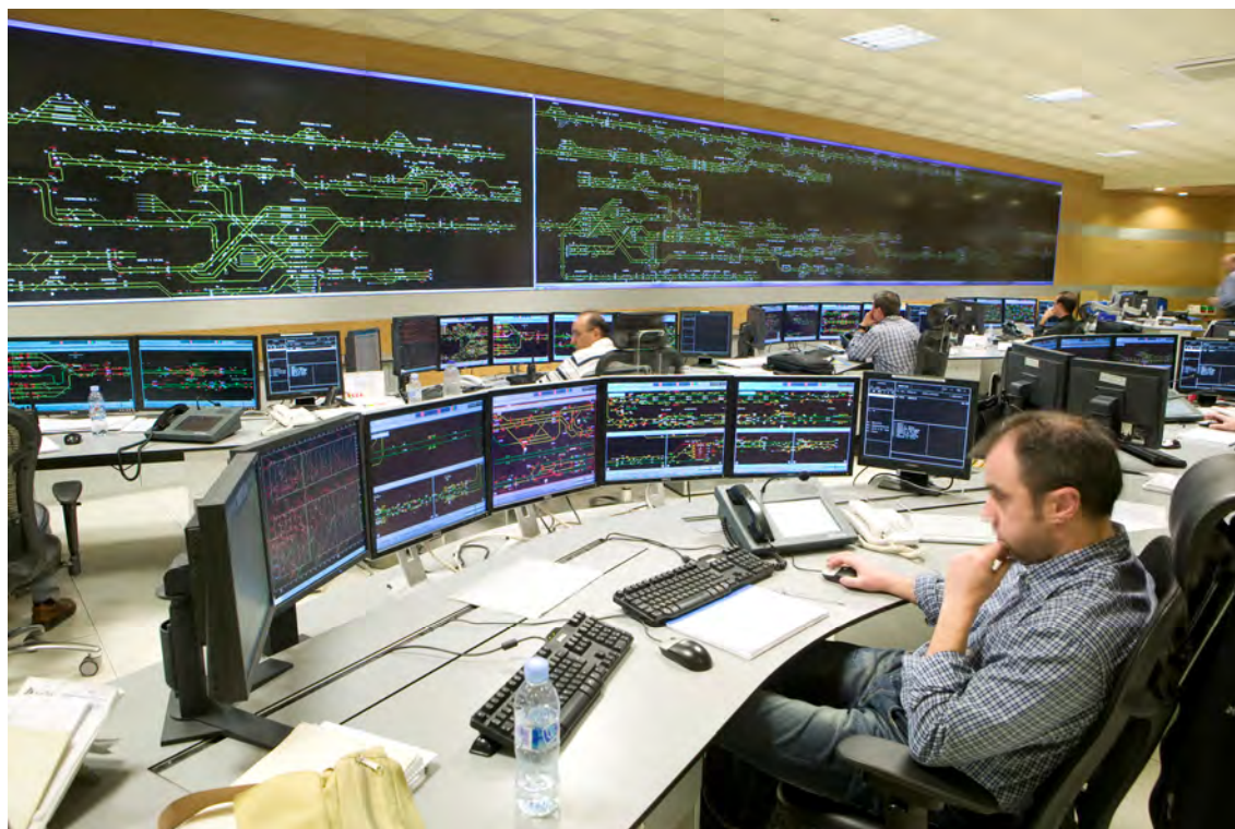
Figura 24. Los puestos de mando recibieron las nuevas tecnologías para gestionar el control del tráfico ferroviario, añadiendo, así, nuevos recursos para garantizar la seguridad de la circulación.
