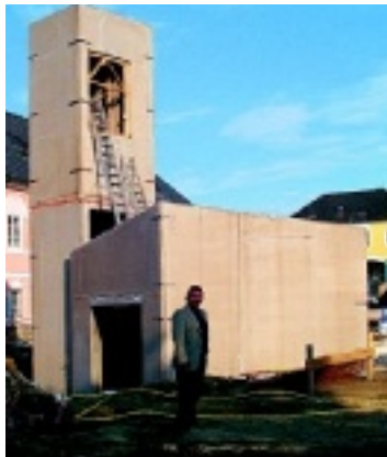
Manfred Hebenstreit auf der Baustelle.
