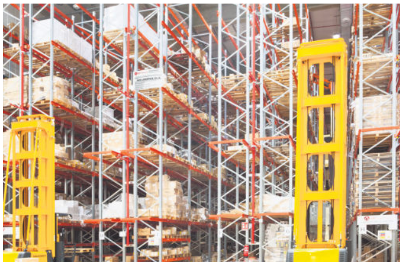
Instalaciones de almacenamiento del operador Aza Logistics.
