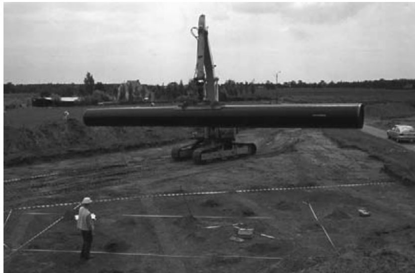
1 Oostwinkel-Mostmolen. Het onderzoek werd bemoeilijkt door de aanvoer van buizen. Oostwinkel-Mostmolen. The research was hampered by the transport of pipes.
