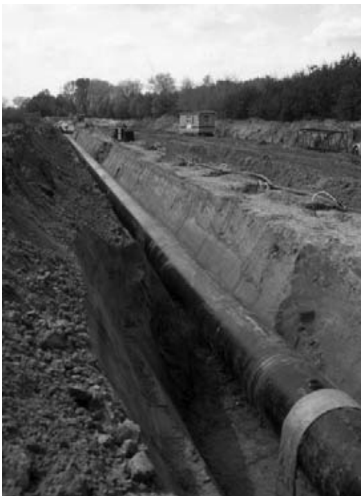
3 Het Houtemveld na het leggen van de buizen in de C-sleuf. The Houtemveld after the digging of deep trench C and installation of the pipeline.
