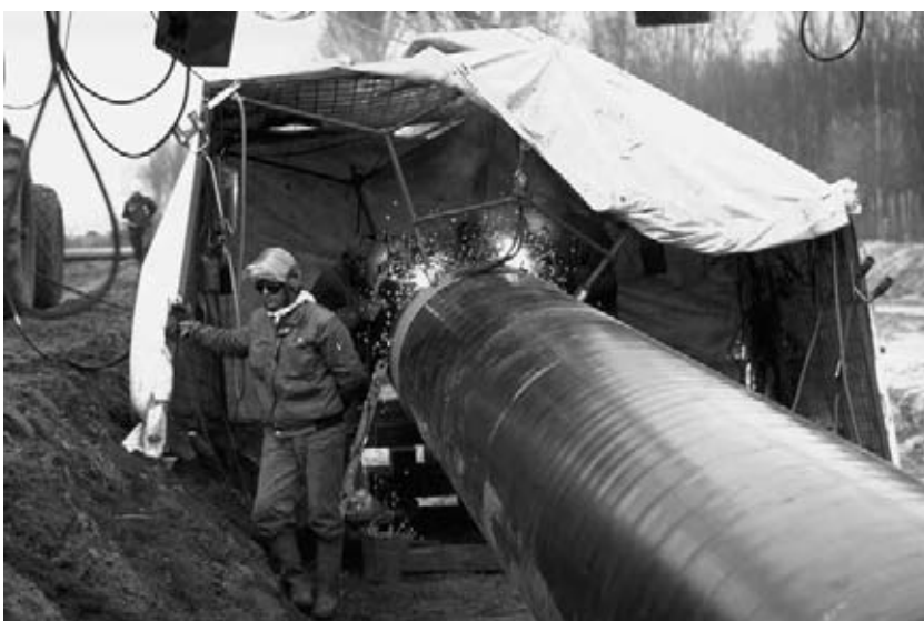
14 Het lassen van de buizen. Welding of the pipes.
