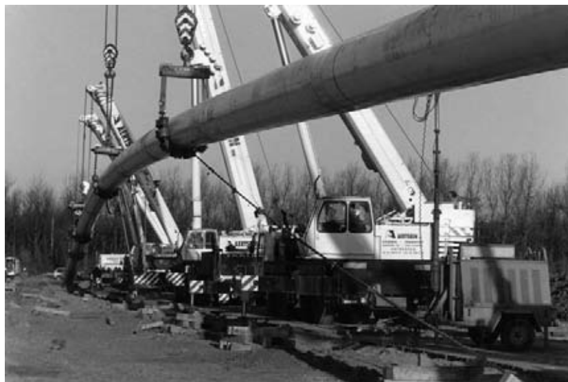
11 De gestuurde boring onder het natuurreservaat 'De Fonteintjes' te Zeebrugge (foto J. Vernieuwe, Brugge). The drilling operation under nature reserve 'De Fonteintjes' at Zeebrugge (photo J. Vernieuwe, Brugge).
